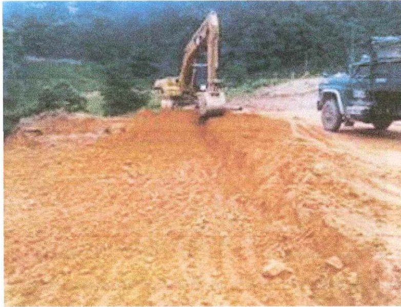
Foto N° 9. Municipio de Sardinata, vereda La Popa. Proceso de corte y nivelación de la locación del pozo San Roque 1.
