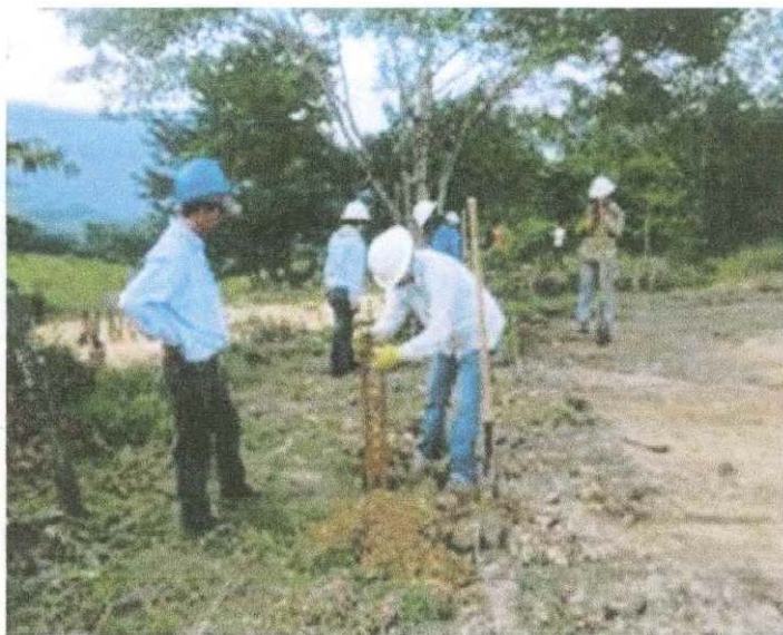
Foto N° 7. Municipio de Sardinata, vereda La Popa. Proceso de cerramiento de la locación.
