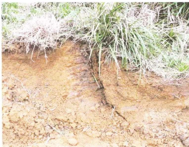
Foto N° 6. Municipio de Sardinata, Adecuación locación pozo San Roque 1. Perfil expuesto.
