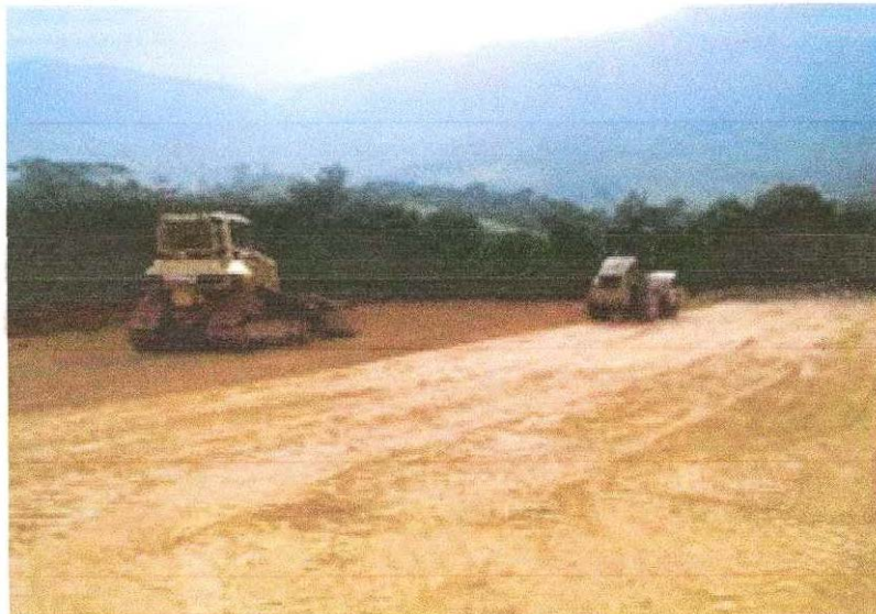
Foto N° 10. Municipio de Sardinata, vereda La Popa. Fase final de nivelación y compactación del área destinada para la locación del pozo San Roque 1.
