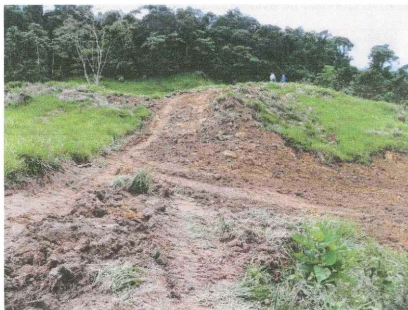
Foto N° 4. Municipio de Sardinata, vereda la Popa. Inicio de las actividades de adecuación de la locación del pozo Roque 1.
