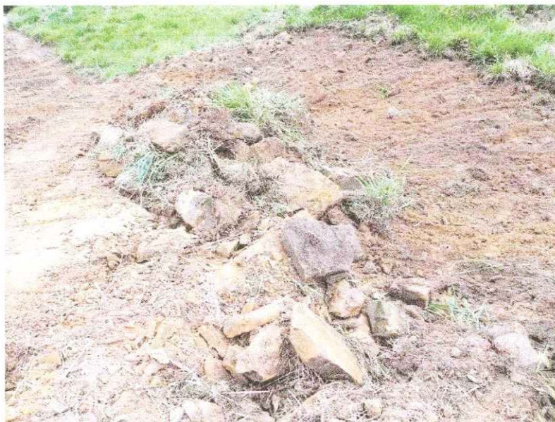
Foto N° 5. Municipio de Sardinata, vereda la Popa. Proceso de descapotaje del área destinada para la locación del pozo San Roque 1. En la imagen se observa la abundante pedregosidad superficial.
