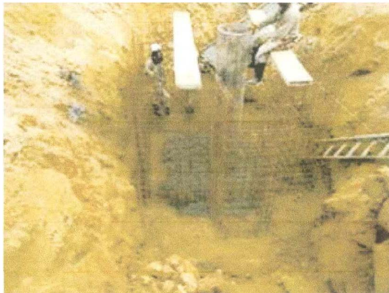
Foto N° 11. Municipio de Sardinata, vereda La Popa. Vista de la construcción del contrapozo de la locación del pozo San Roque 1.
