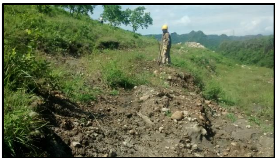
Imagen 27 Área y proceso de excavación del pozo de sondeo 9.
