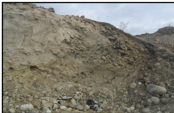
Imagen 66 Columna levantada. Fuente: Vergara, 2016
