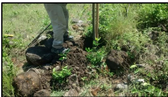
Imagen 44 Proceso de excavación del pozo de sondeo 17
