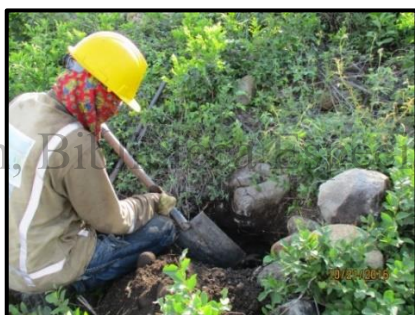
Imagen 59 Proceso de excavación del pozo de sondeo 25
