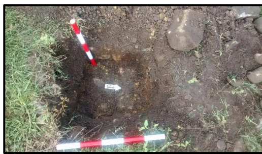
Imagen 11 Final de excavación del pozo de sondeo 1
