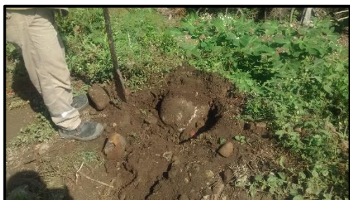
Imagen 19 Proceso de excavación del pozo de sondeo 5.
