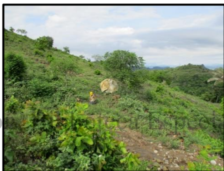
Imagen 17. Área y proceso de excavación del pozo de sondeo 4.
