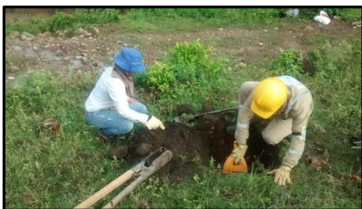
Imagen 10 Proceso de excavación pozo de sondeo 1
