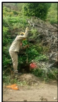
Imagen 15 proceso de excavación pozo de sondeo
