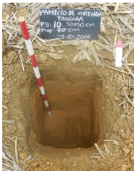
Foto 8. Pozo de sondeo con capas 1 y 2 ausentes
