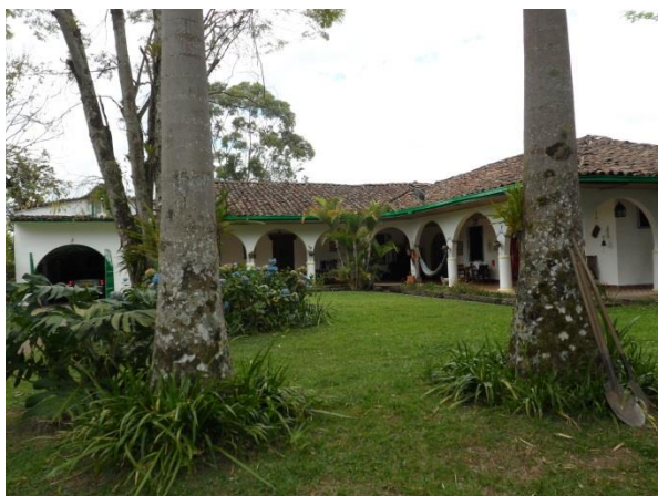
Foto 25. Casa principal hacienda el Cannan. Predio no adquirido.
