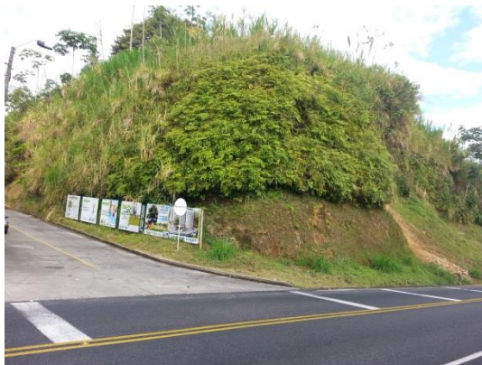
Foto 15. Vía principal rumbo Armenia. Vista general sector norte – pendientes – del predio, cortes para la adecuación de las vías.
