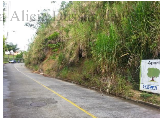
Foto 14. Vía acceso sector Cannan, Vista pendiente sector Noreste del predio.
