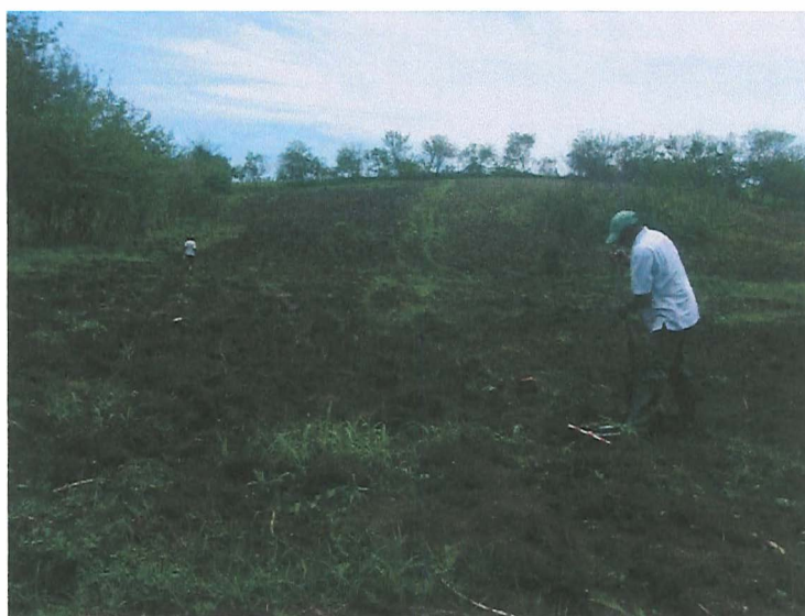
Foto N° 7. Locación del Pozo Apamate 2. Municipio de San Pedro, departamento de Sucre. Proceso de excavación de los pozos de sondeo en el área de ladera.
