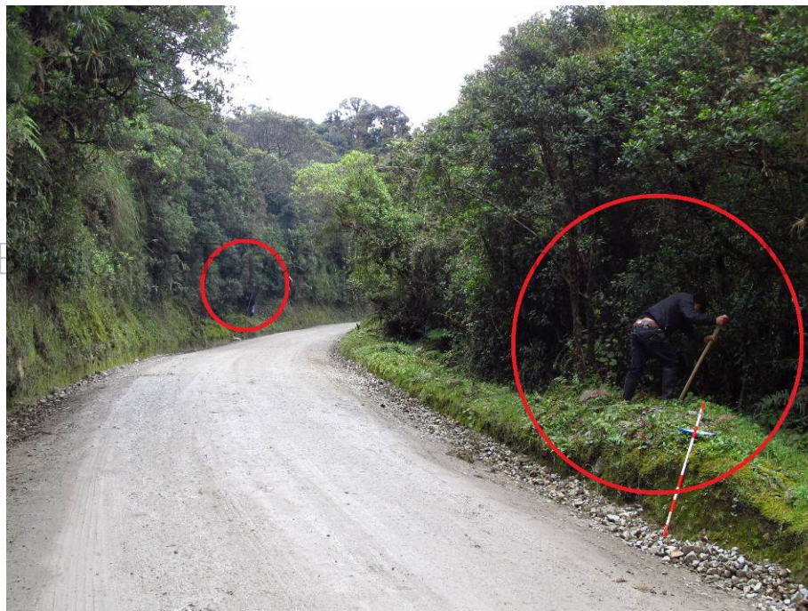
Fotografía 1. Espaciado buscado entre sondeos en condiciones que no evidenciaban a simple vista un alto grado de alteración.
