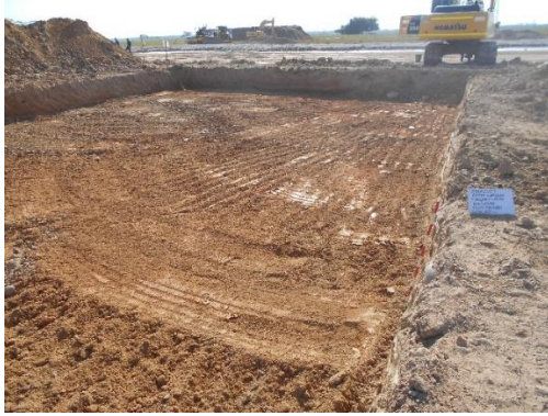
Fotografía 19. Excavación para placa-taladro
