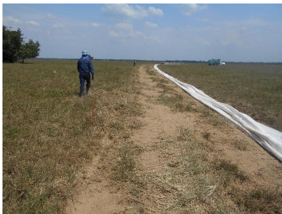
Fotografía 26. Apertura de vía nueva. Tramo V-01
