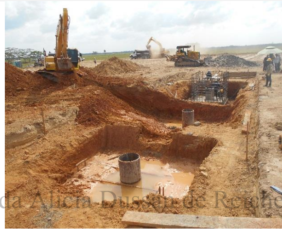
Fotografía 22. Obras civiles en contrapozos
