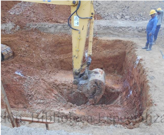
Fotografía 21. Excavación de pozos
