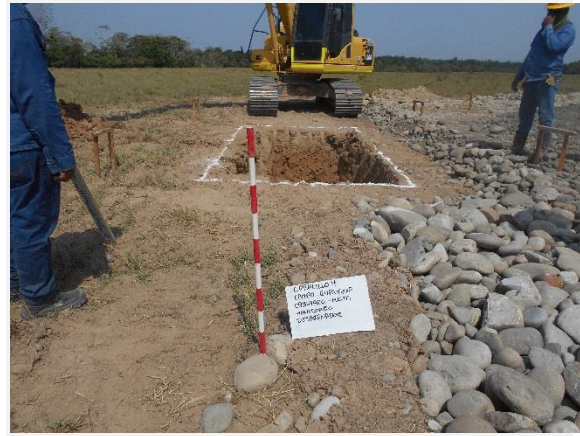
Fotografía 24. Excavación de desarenador
