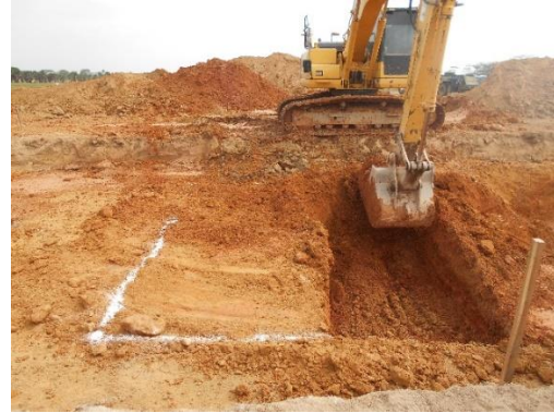
Fotografía 20. Excavación de contrapozos
