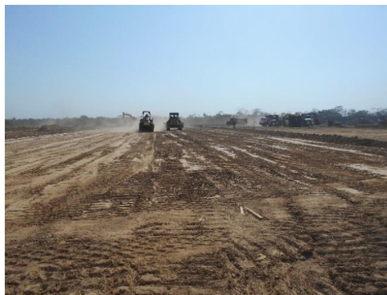
Fotografía 16. Avance de corte
