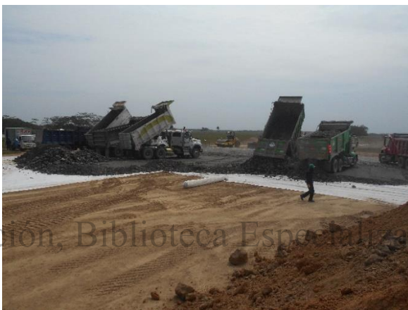
Fotografía 17. Relleno de plataforma
