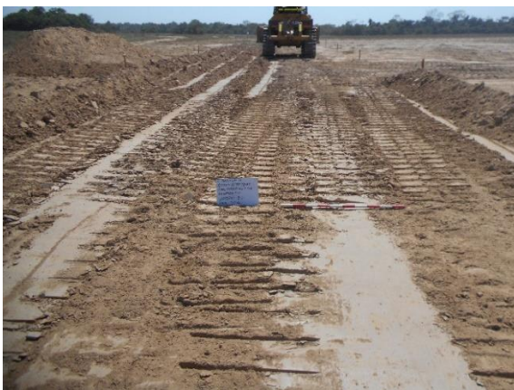
Fotografía 15. Corte de 20 cm en plataforma
