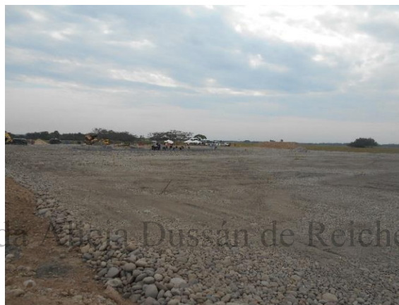
Fotografía 18. Relleno de plataforma
