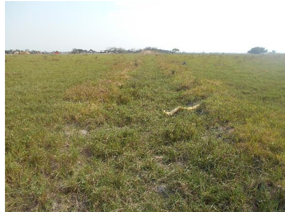
Fotografía 14. Canal de desagüe
