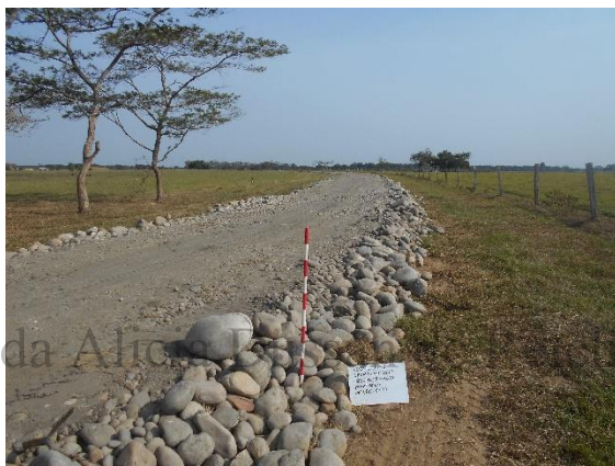
Fotografía 28. Adecuación de vía de acceso
