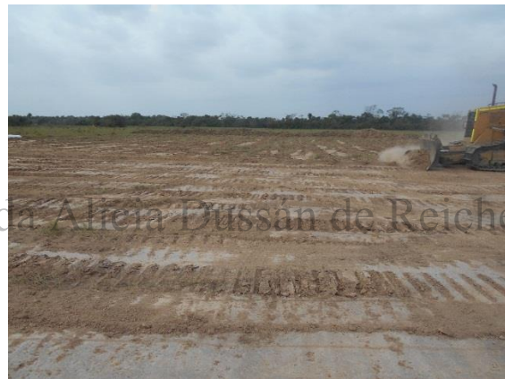
Fotografía 10. Avance de descapote
