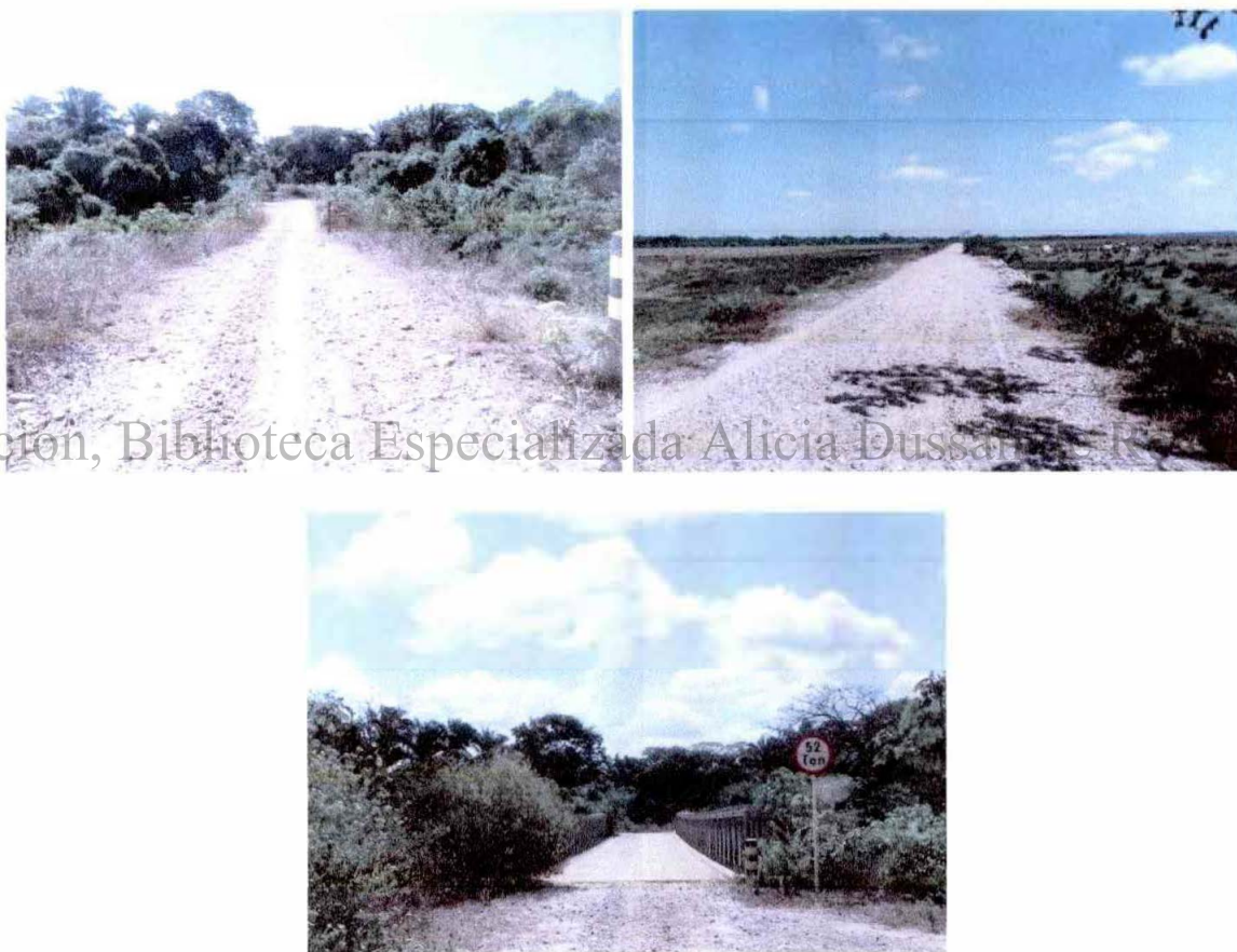
Foto N° 3. Municipio de Orocué, vista de la vía de acceso y del puente que cruza el caño Guanapalo, en las imágenes se alcanza a apreciar el terraplén sobre el cual va la vía.
