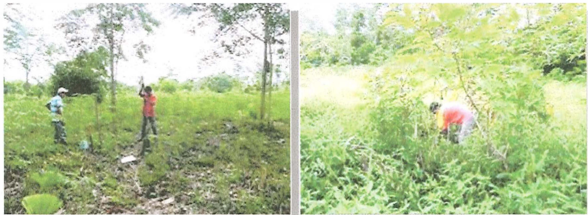
Fotografía 6-16. Municipio de Puerto Guzmán, vereda Puerto Rosario, locación Canelo Sur 2. Excavación de pozos de sondeo.
