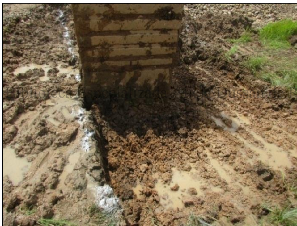
Fotografía 4-8 Adecuaciones del terreno para disponer el Desarenador 1
