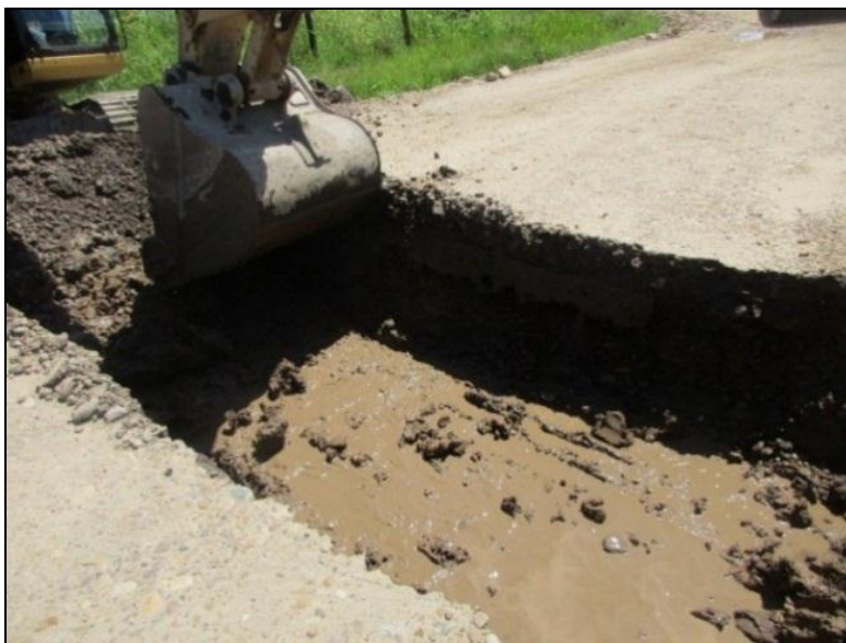
Fotografía 4-11 Excavaciones para la construcción de nueve alcantarillas
