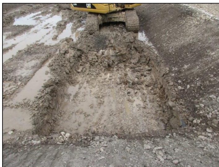
Fotografía 4-6 Excavación con maquinaria para la disposición de una piscina
