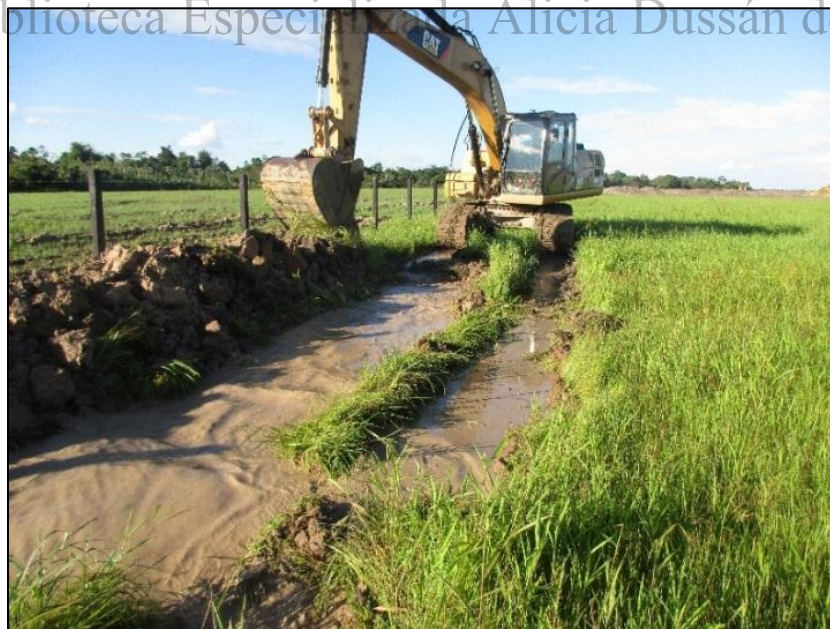
Fotografía 4-14 Excavación para la disposición del Canal perimetral 3
