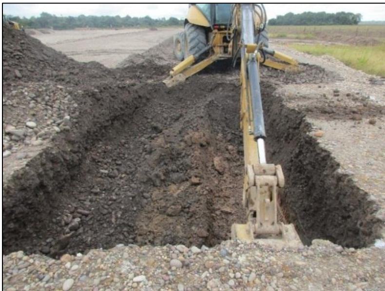
Fotografía 4-10 Adecuación de un skimmer asociado a la construcción de la piscina
