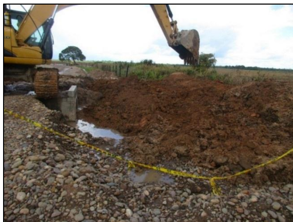
Fotografía 4-12 Adecuación de la conexión canal de irrigación
