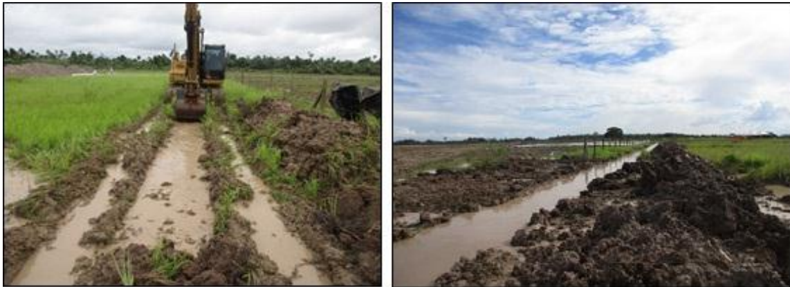
Fotografía 4-13 Excavación para la disposición del Canal perimetral 1 (izq.) y Canal perimetral 2 (der.)
