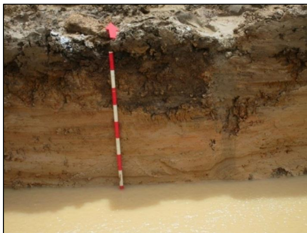
Fotografía 4-16 Canal de irrigación colmatado por actividad agrícola.
