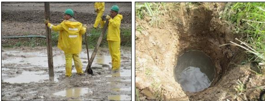
Fotografía 4-15 Actividades asociadas a la construcción de un cercado
