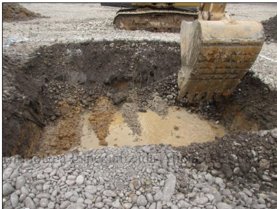
Fotografía 4-7 Excavación con maquinaria para la construcción de un Contrapozo
