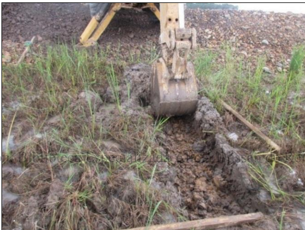
Fotografía 4-9 Adecuaciones del terreno para disponer el Desarenador 2
