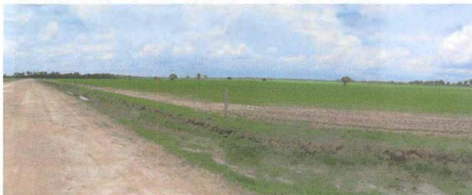
Foto N° 37. Punto de observación del sitio de interés U, obsérvese el paso de la carretera veredal, la cual va sobre un terraplén.
