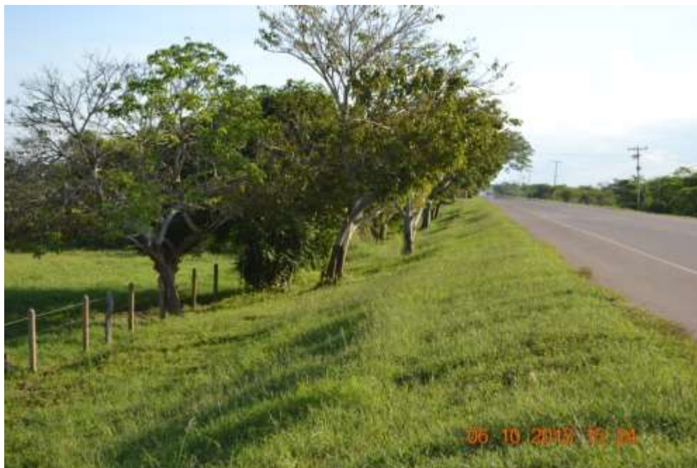
Lamina 3. Esta foto corresponde a la carretera que une Barranquilla con el Municipio de Calamar. Es un dique que protege los suelos que están a la derecha de las arremetidas del río Magdalena que está ubicado a la izquierda. Obsérvese la marca en los troncos de los árboles, que indica hasta donde alcanza el nivel del agua en la estación de invierno. El corredor vial que se construirá entre Magangué y Mompóx, será semejante.
