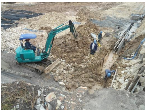
Imagen 37 Excavación mecánica
