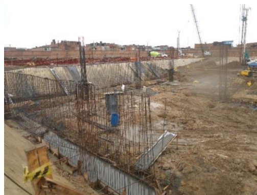
Imagen 38 Instalación de refuerzo acero
