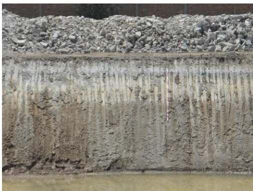
Imagen 46 Perfil occidental excavación En este perfil se evidencia la estratigrafía tipo de la zona (sin intervención de obras de infraestructura). Un primer horizonte orgánico casi inexistente en compañía de algunos rellenos de escombros. Un horizonte gris con un subyacente horizonte argílico oscuro muy definido. Las capas inferiores muestran las correspondientes manifestaciones de arcillas y arenas intercaladas, estériles culturalmente. Tamaño de la escala 250 cm
