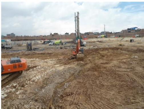
Imagen 29 Fase final costado oriental – sótano 2
