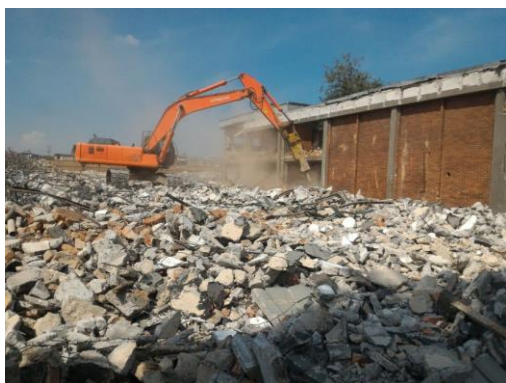
Imagen 13 Demolición edificio principal
