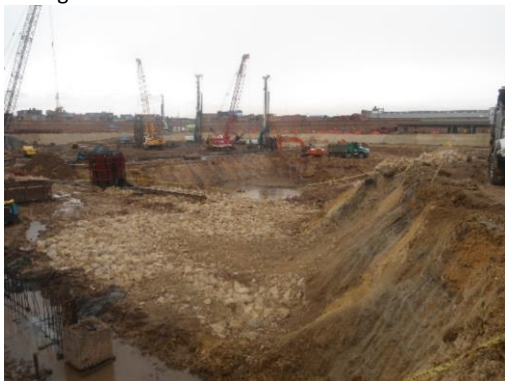
Imagen 31 Fase final sótano 2
