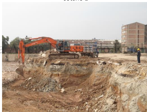
Imagen 26 Acompañamiento al movimiento de tierras costado occidental - sótano 1
