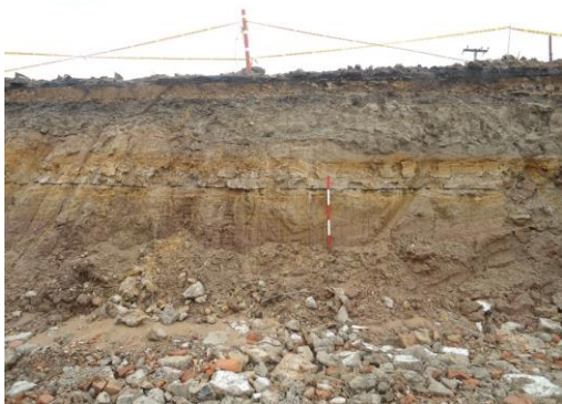
Imagen 54 Perfil área centro occidental bajo capa de asfalto
