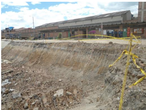
Imagen 48 Perfil norte excavación
