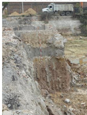
Imagen 59 Detalle perfil central bajo placas de concreto Tamaño de la escala 250 cm
