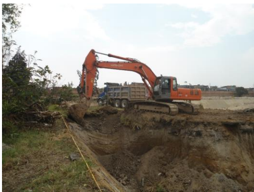
Imagen 27 Acompañamiento al movimiento de tierras costado oriental - sótano 1
