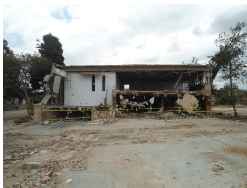
Imagen 14 Subestación en proceso de demolición
