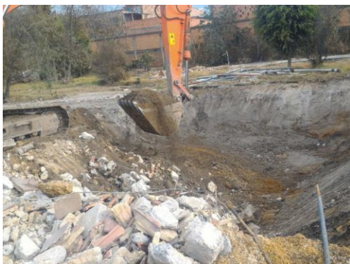
Imagen 23 Inicio excavación mecánica - sótano 1
