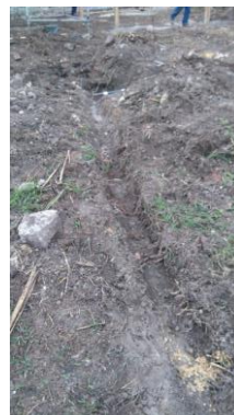
Imagen 22 Zanjas para construcción de campamento
