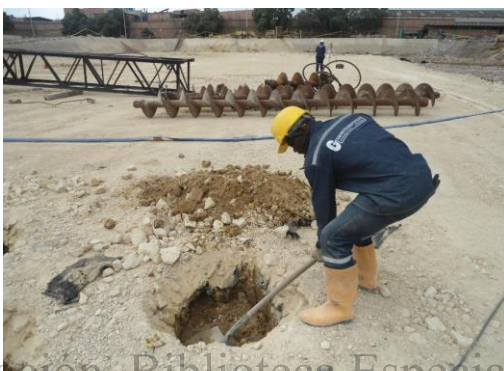
Imagen 19 Excavación manual para pilotes
