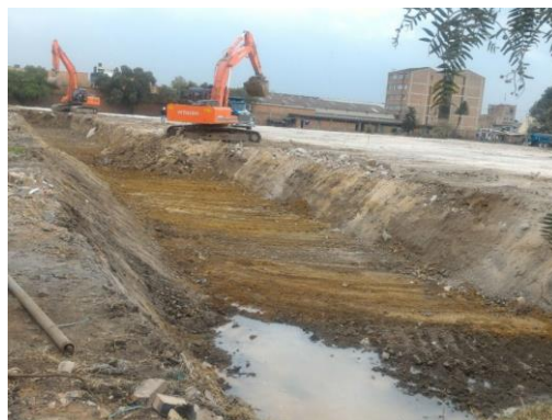
Imagen 24 Primeras etapas excavación mecánica – sótano 1
