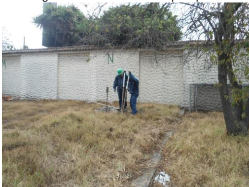
Imagen 21 Excavación para postes de alumbrado
