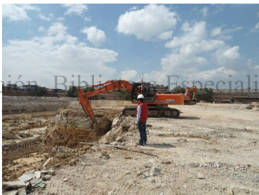
Imagen 25 Acompañamiento al movimiento de tierras sector central - sótano 1
