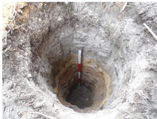
Imagen 43 Instalación postes alumbrado Área adyacente a la vía y muro perimetral con un horizonte superficial compuesto de material orgánico y rellenos más profundos de material arenoso. Tamaño de la escala 50 cm
