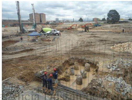
Imagen 40 Área excavada adyacente a pilotes
