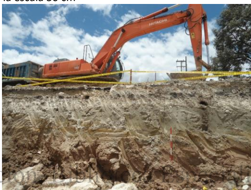
Imagen 56 Perfil área central bajo placas de concreto Tamaño escala 50 cm
