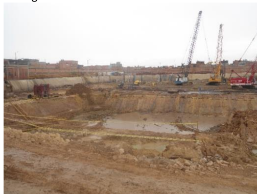
Imagen 32 Taludes – sótano 2
