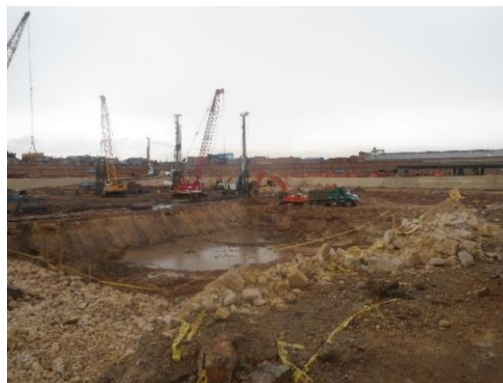
Imagen 30 Excavación sótano 2 costado oriental
