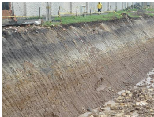
Imagen 49 Perfil oriental excavación
