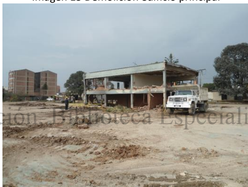
Imagen 15 Demolición subestación
