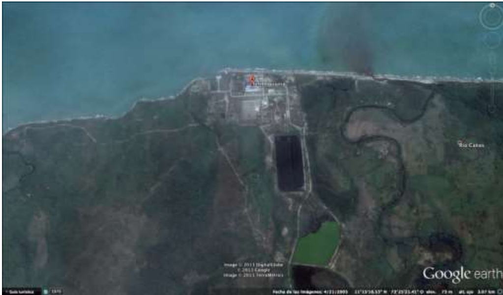
Figura 12. Se muestra el área en general donde se ubica la planta y la desembocadura del río Cañas a la derecha.
