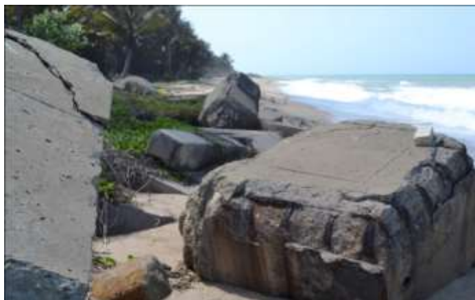
Figura 7. En la playa han construido muros de contención que han sido destruidos por la fuerza de las olas.
