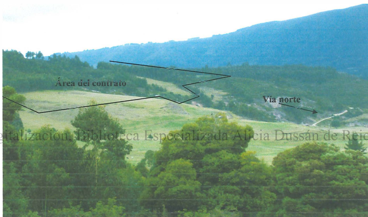
Fotografía 1. Panorámica del área del contrato y la vía de acceso por el norte del área del contrato
