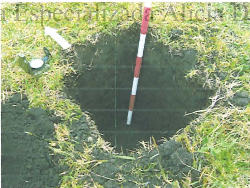
Fotografías 23, 24 y 25. Trabajo de apertura de un pozo y su posterior análisis
