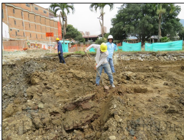
Foto 18, 19 y 20. Apertura de Pozos en Pisos Duros.
