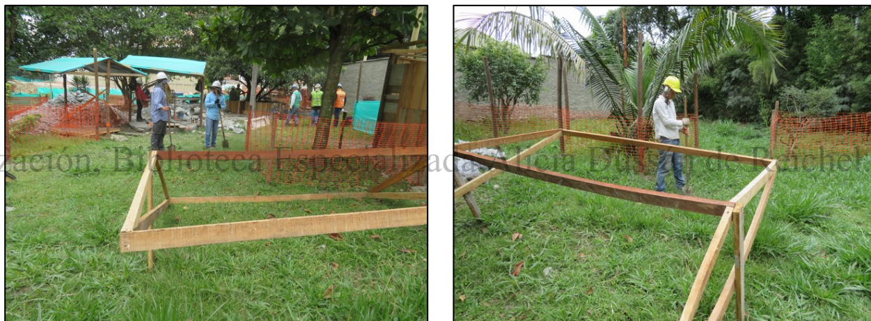
Foto 13 y 14. Apertura de Pozos en ZV1.
