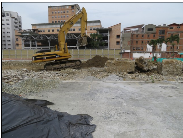
Foto 21, 22, 23, 24, 25 y 26. Inspección levantamiento y demolición de Pisos Duros.
