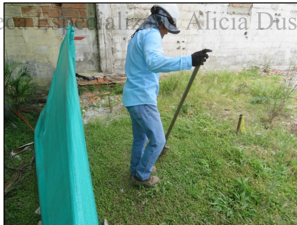
Foto 15, 16 y 17. Apertura de Pozos en ZV2.
