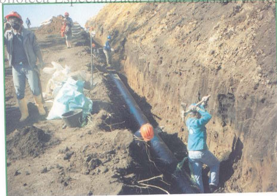
Foto 2: Apertura de la zanja.
