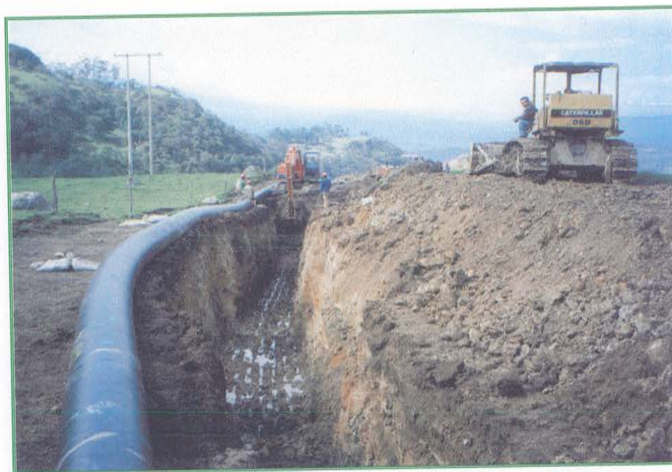
Foto 11: Monitoreo al zanjado en la abscisa K 2+800.
