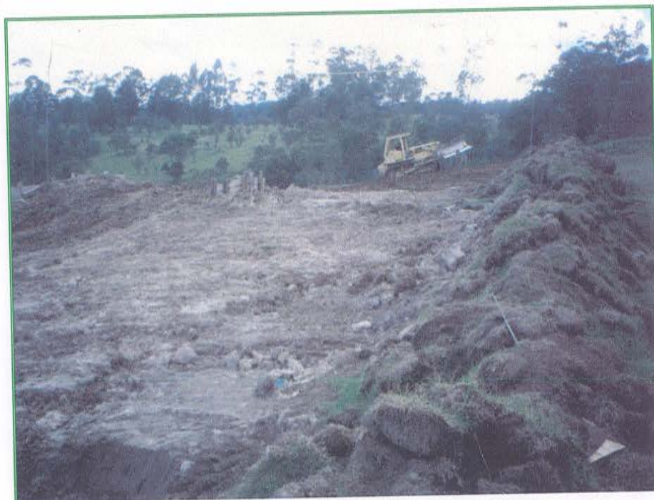
Foto 1. Adecuación del derecho de vía. Descapote
