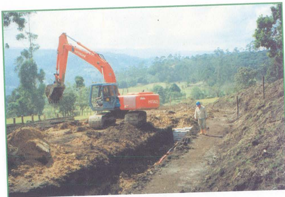
Foto 15: Monitoreo al zanjado en la abscisa K 9+100.
