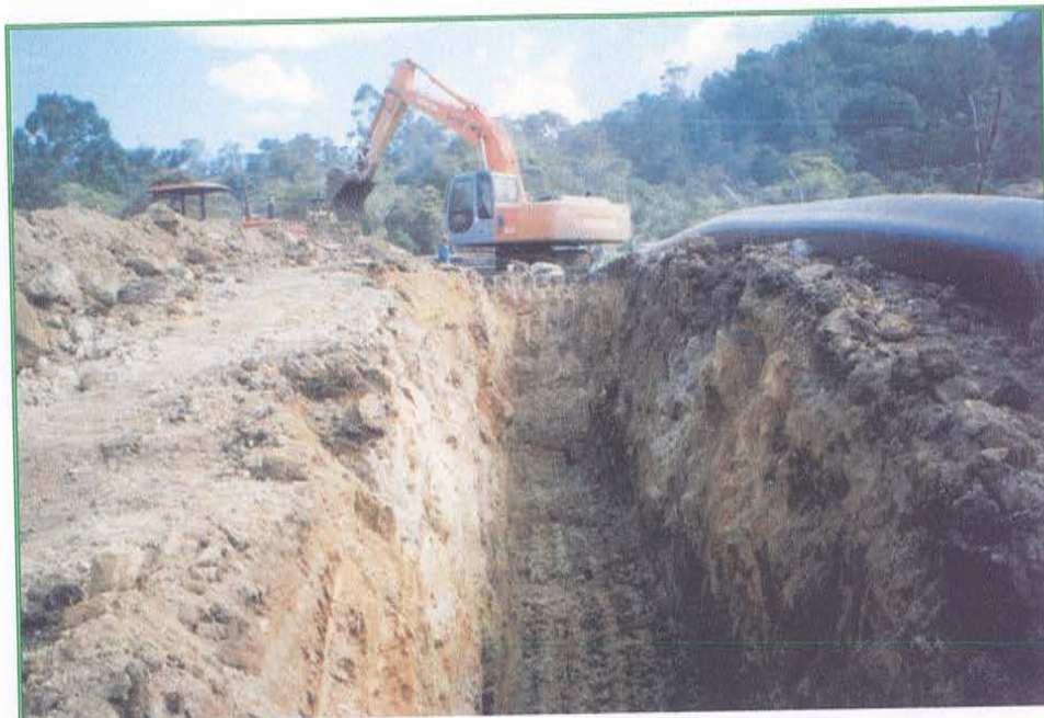
Foto 3: Apertura de la zanja.
