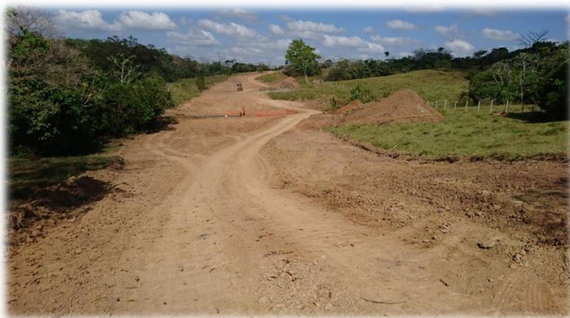
Fotografía 32. Km 3+000 al km2+750 vista sur-norte.
