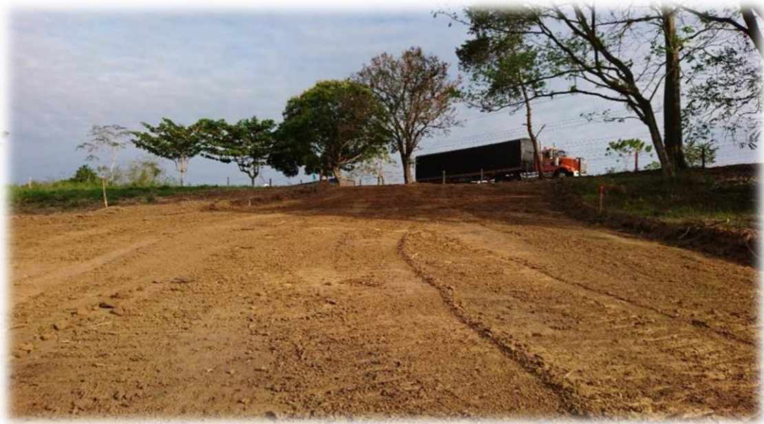
Fotografía 20. Km 0+000 descapote finalizado, al fondo carretera a Montería.
