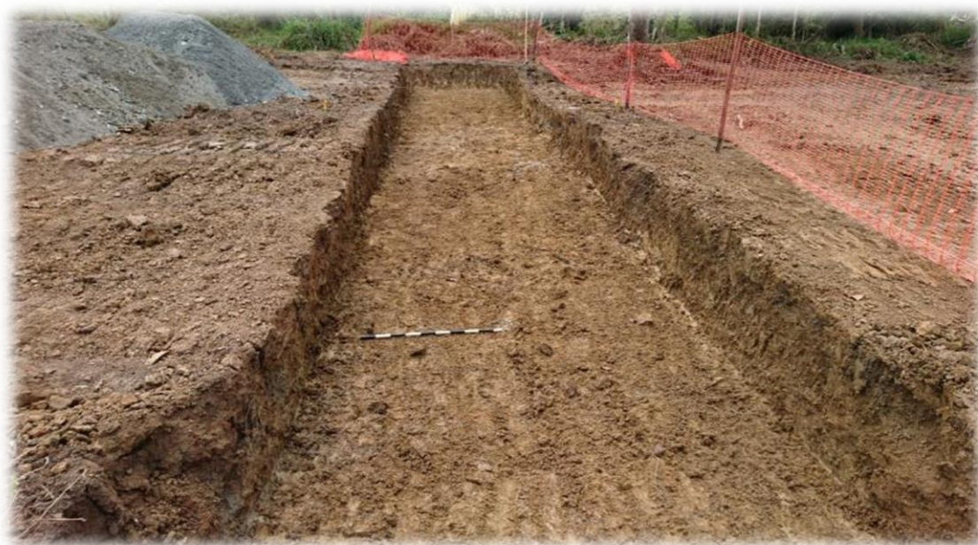
Fotografía 23. Km 0+040 excavación para box coulvert.
