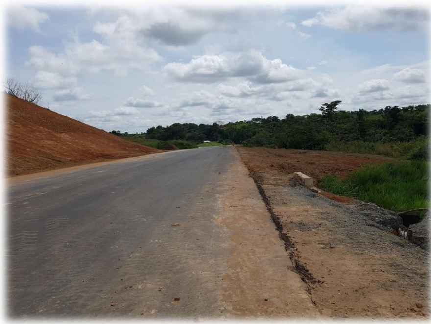
Fotografía 48. Estado de las obras a finales de 2018.
