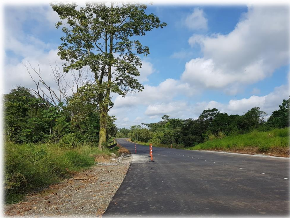
Fotografía 47. Estado de las obras a finales de 2018.
