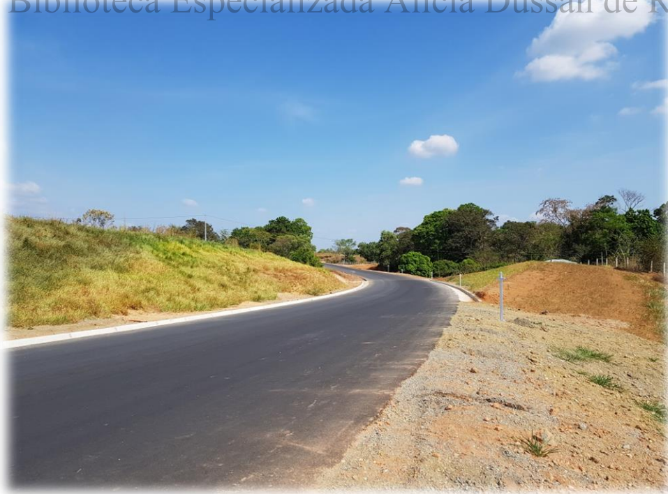
Fotografía 51. Estado de las obras a finales de 2018.
