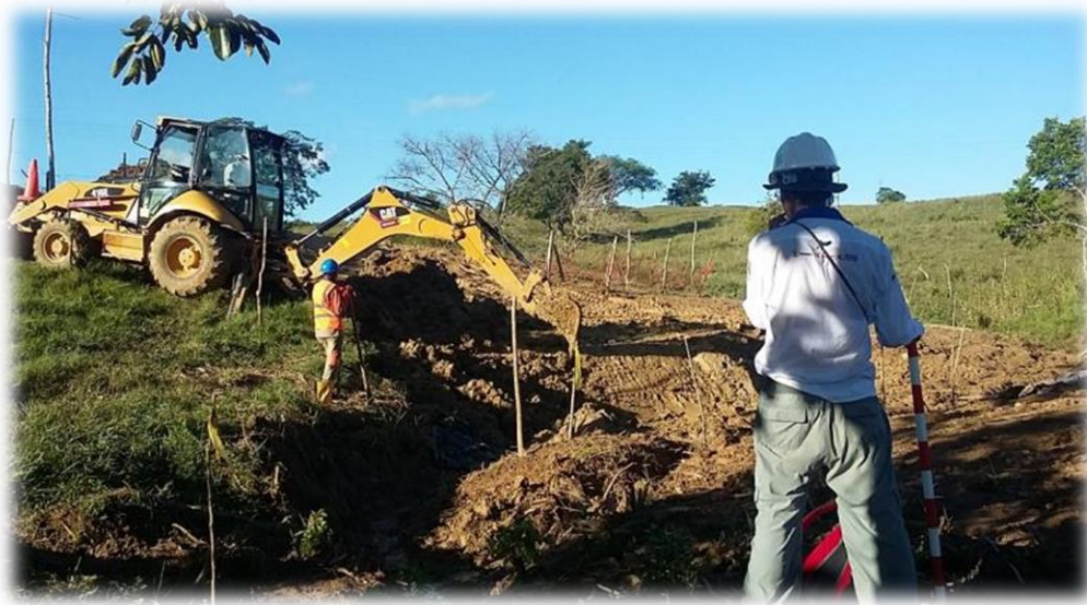
Fotografía 7. Inspección visual a actividades de remoción de tierras Km 2+ 500 Hito 18.
