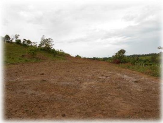
Fotografía 18. Zona descapotada con Buldócer, km 2+990 .
