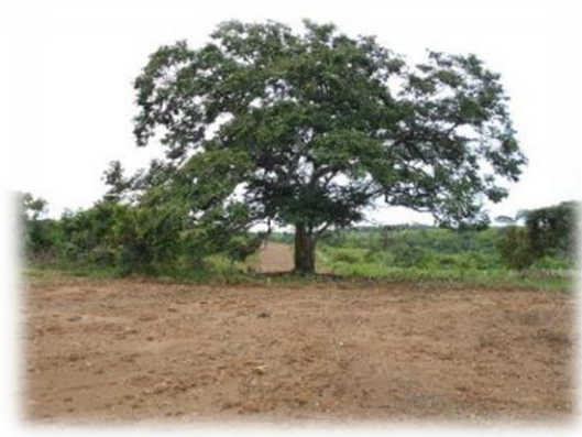
Fotografía 19. Zona descapotada con Buldócer, km 2+990 .
