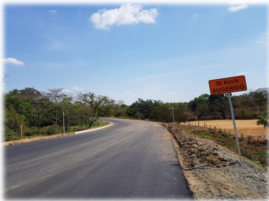
Fotografía 49. Estado de las obras a finales de 2018.
