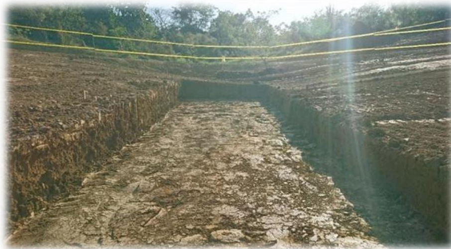
Fotografía 29. Km 0+940 excavación de box. NO se encuentra material cultural.
