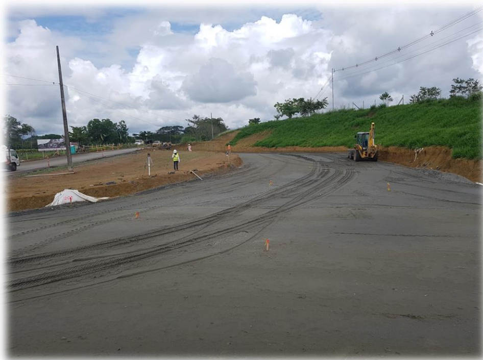
Fotografía 46. Estado de las obras a finales de 2018.
