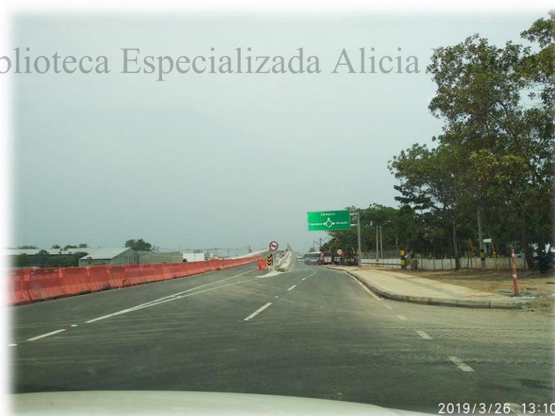
Fotografía 56. Estado final de la vía al momento previo a su entrega / finalización del Monitoreo Arqueológico.
