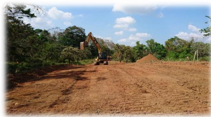
Fotografía 26. Km 1+000 avance del descapote.
