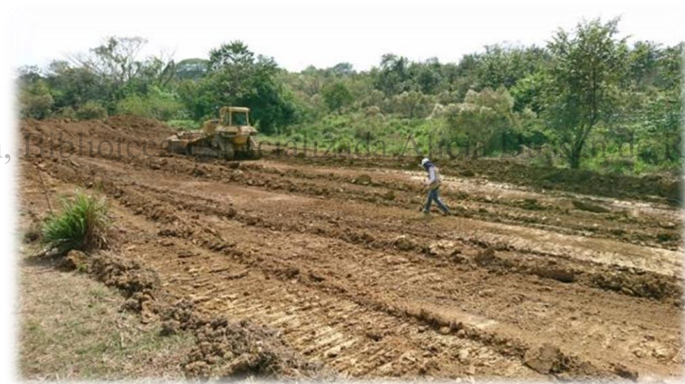
Fotografía 8. Inspección visual detallada realizada a la par de las obras de descapote ( Km 1+450 monitoreo de descapote con buldócer).
