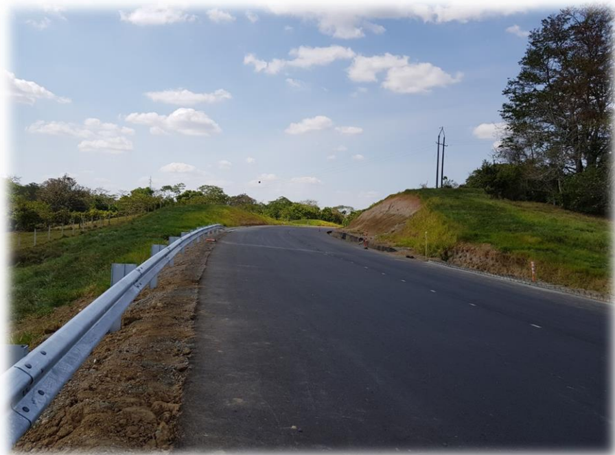
Fotografía 50. Estado de las obras a finales de 2018.
