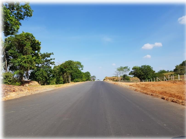
Fotografía 52. Estado de las obras a finales de 2018.
