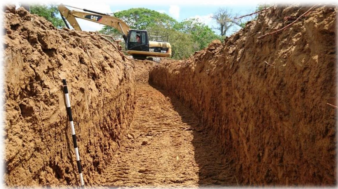
Fotografía 22. Km 0+090 trinchera para control de cauce.
