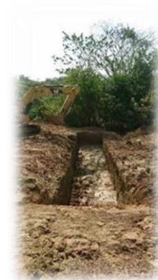
Fotografía 25. Km 1+610 excavación de box Coulvert, NO aparece material arqueológico.
