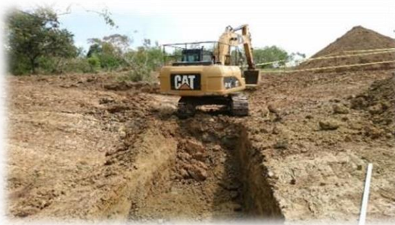
Fotografía 24. Km 1+610 excavación de box Coulvert, NO aparece material arqueológico.
