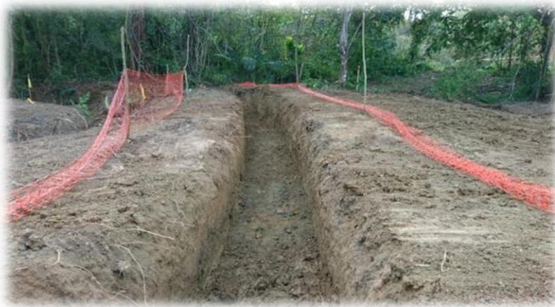
Fotografía 27. Km 1+090 trinchera excavada para control de cauce.
