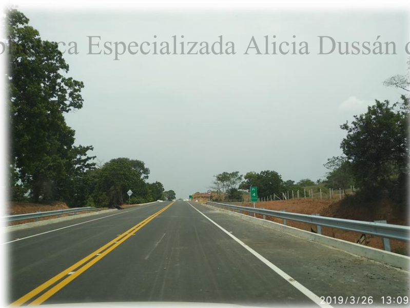
Fotografía 54. Estado final de la vía al momento previo a su entrega / finalización del Monitoreo Arqueológico.
