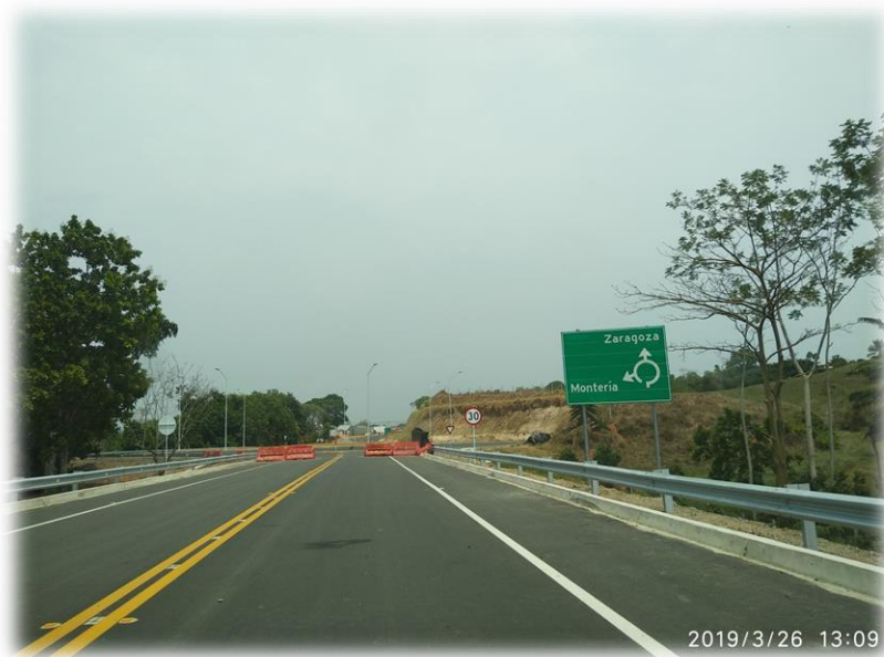
Fotografía 55. Estado final de la vía al momento previo a su entrega / finalización del Monitoreo Arqueológico.
