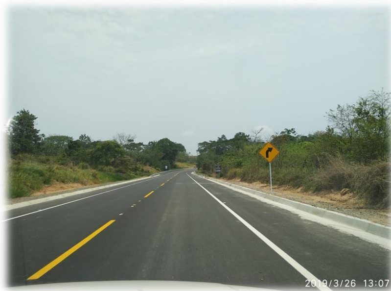
Fotografía 53. Estado final de la vía al momento previo a su entrega / finalización del Monitoreo Arqueológico.
