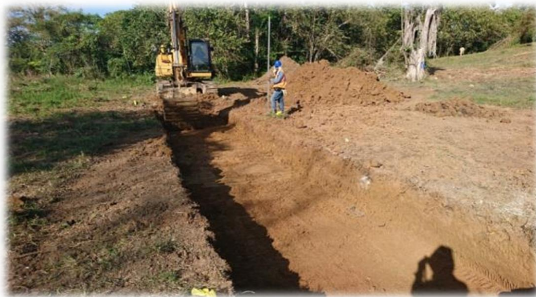
Fotografía 31. km 0+500 excavación para box en esa planicie. NO se registra material.
