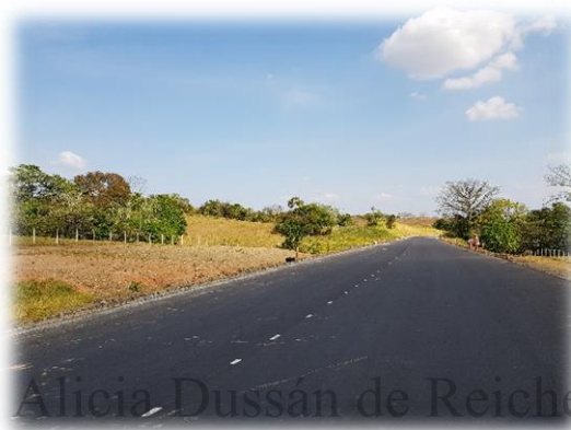
Fotografía 3. Estado final del tramo Variante Caucasia.
