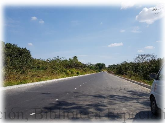
Fotografía 2. Estado final del tramo Variante Caucasia.
