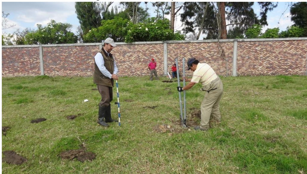
Fotografía 3. Realización pozos de sondeo
