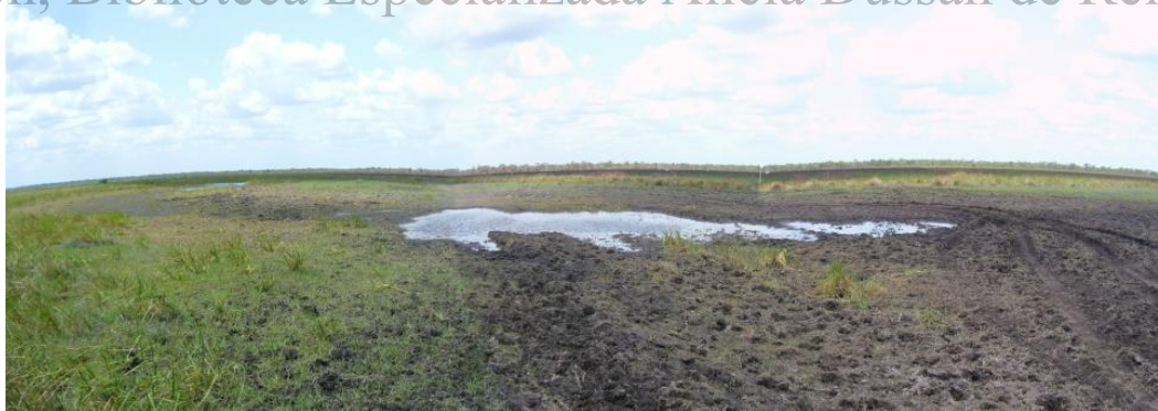
Fotografía 18. Panorámica de la vía en el Tramo 2
