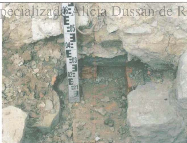
Fotografía 37. Cañuela en cimientos de casa
