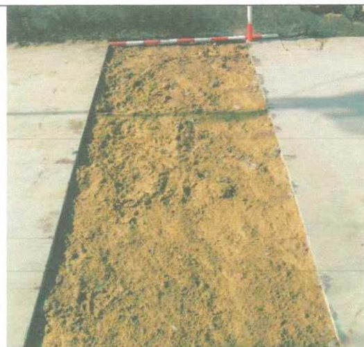
Fotografía 54. Aspecto de localización de baldosa
