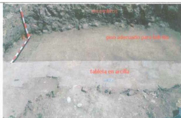
Fotografía 60. Adecuación de pisos para colocar tableta en la unidad E
