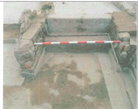
Fotografía 49. Mal formación de acceso, con material reutilizado
