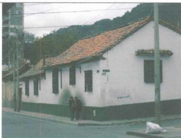
Fotografía 12. Casa de una planta cerca al templo de Santa Bárbara
