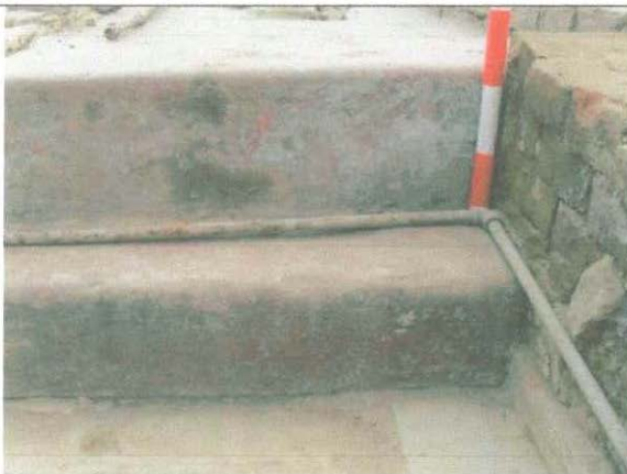
Fotografía 48. Escalón de acceso a planta de habitación, huella y contrahuella de 20 cms.
