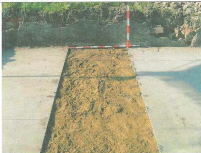
Fotografía 55. Sobre arena se colocaron las hiladas de baldosa
