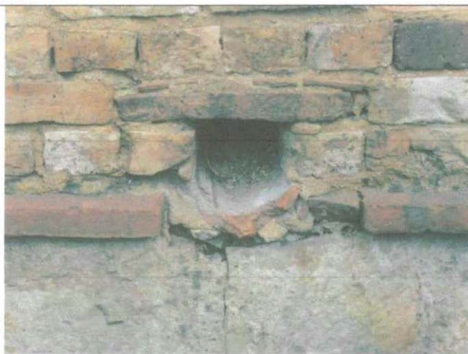
Fotografía 38. Sistema de desagüe del templo Santa Bárbara. Detalle
