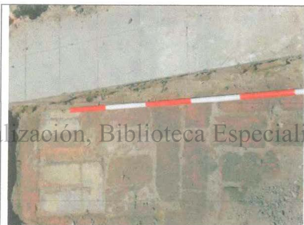
Fotografía 32. Piso en ladrillo y baldosa adicional
