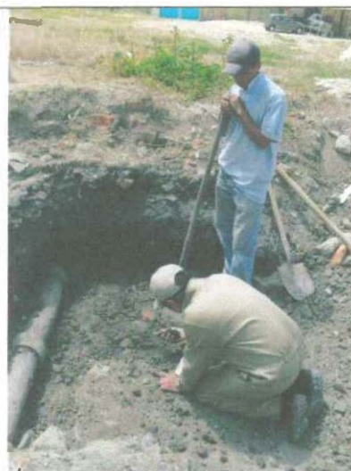
Fotografía 21. Excavación de sitio carrera 6ª
