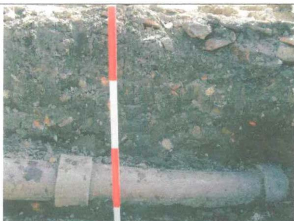
Fotografía 20. Perfil de obra con tubería moderna. Carrera 6ª
