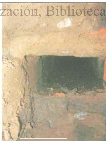
Fotografía 36. Sistema de desagüe en cañuela (Mompox)
