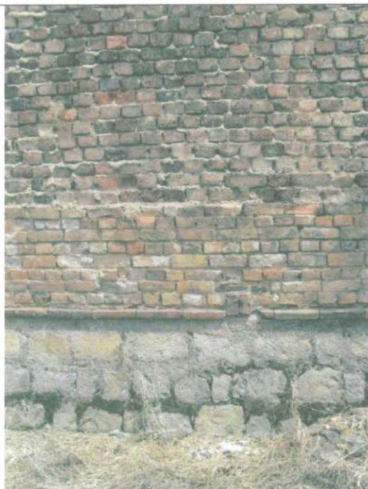
Fotografía 34. Sistema constructivo del templo
