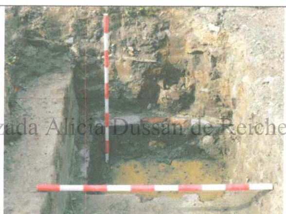
Fotografía 33. Sistema de construcción, tableta y ladrillo
