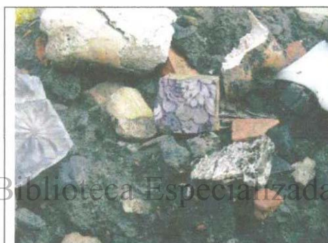
Fotografía 26. Evidencias de materiales en el muro de tapia pisada
