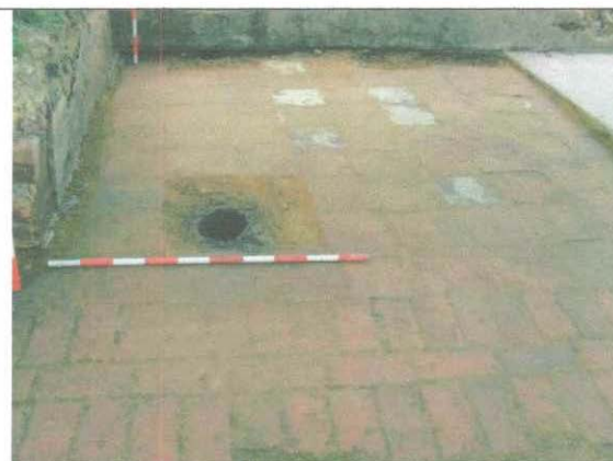
Fotografía 59. Sobre el piso se colocó una capa de arena Para la baldosa como aspecto de modernidad
