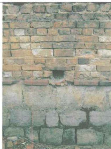
Fotografía 39. Desagüe y ubicación en la construcción
