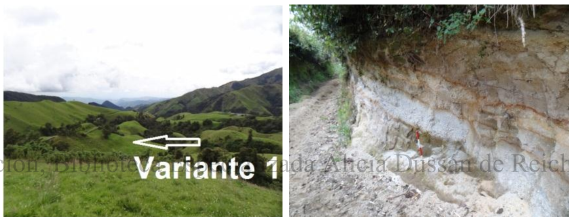
Figura 8. Imágenes del sector 1, variante 1 tramo medio, final y talud expuesto en camino de herradura
