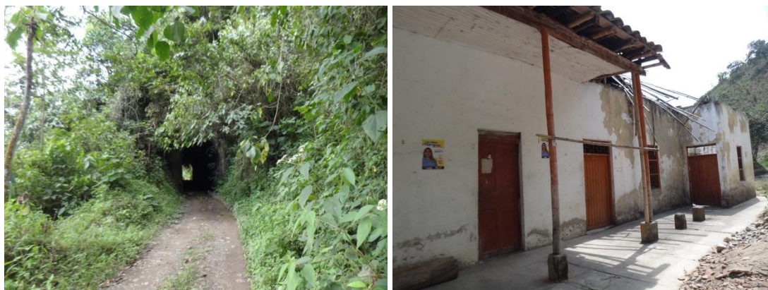
Figura 52 Vista de túnel del ferrocarril en la parte baja de la ladera, antiguo campamento de personal que trabajó en el mantenimiento de la línea férrea.
