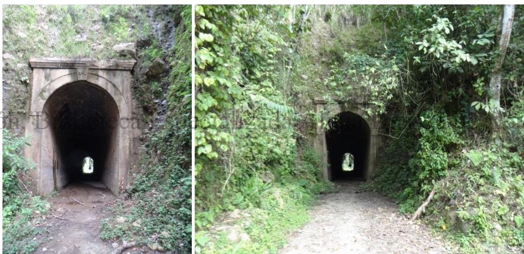
Figura 7. Vista por los dos costados del Túnel n°8, junto a la quebrada Chupaderos, municipio de Villamaría.
