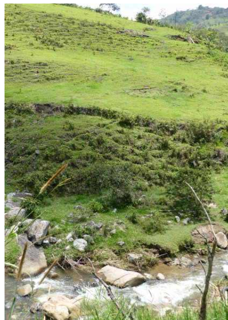
FOTO 27. TALUD MARGEN IZQUIERDA QUEBRADA LA HONDA
