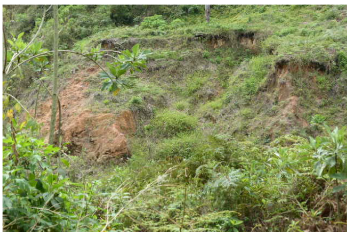
FOTO 24. TALUDES EXPUESTOS (VÍA DE ACCESO A TÚNEL DE LODOS)
