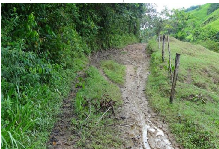
FOTO 13. VIA EXISTENTE DE DONDE PARTE LA VIA A CASA DE MAQUINAS
