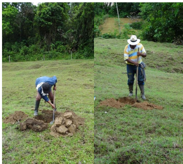
FOTO 16. EXCAVACIÓN DE POZOS DE SONDEO EN LA UMA 4
