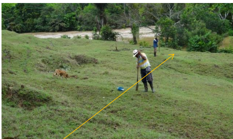
FOTO 14. EJE DEL TRAZADO DE LA VIA A CASA DE MAQUINAS
