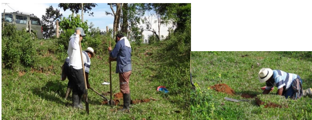
FOTO 6. EXCAVACIÓN DE POZOS DE SONDEO EN LA UMA 2
