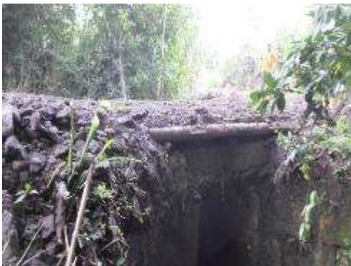
Fotografía 5-15. Instalación sobre puente Puente 3. 6
