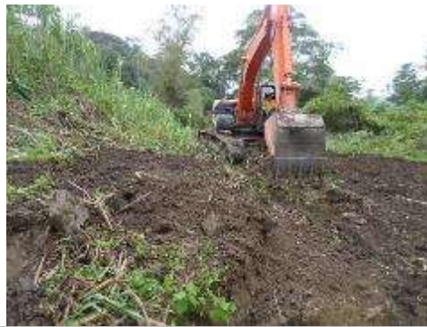
Fotografía 5-1 Monitoreo derecho de vía. Construcción Caseta de válvulas.
