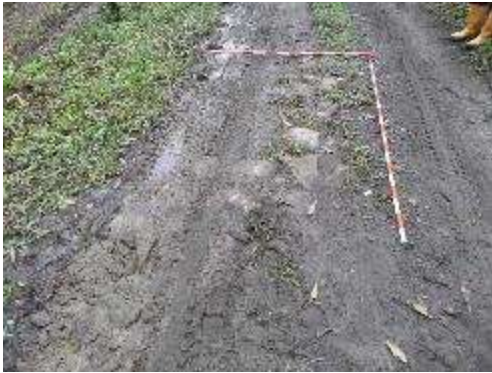
Fotografía 5-13. Punto 35. Camino real. Punto 8. Cerca a la obra Coordenadas GPS E: 955339 N: 1039453
