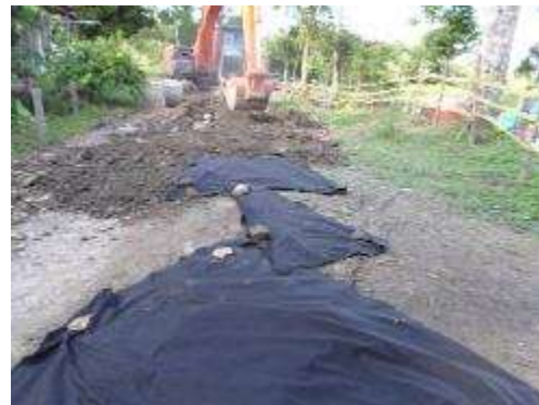
Fotografía 5-16. Instalación geotextil Camino Real. Punto 6. 7
