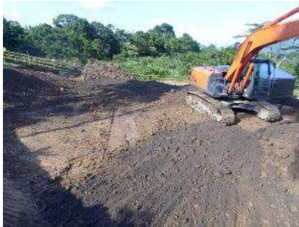
Fotografía 5-2 Monitoreo Costado sur del Cruce Quebrada el Cuartillo (CQC).
