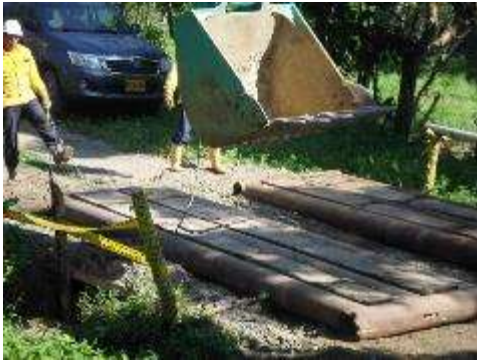
Fotografía 5-17. Instalación sobre puente.
