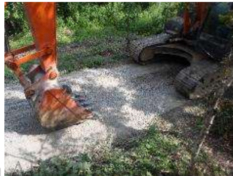
Fotografía 5-20. Instalación geotextil Punto 9. 9
