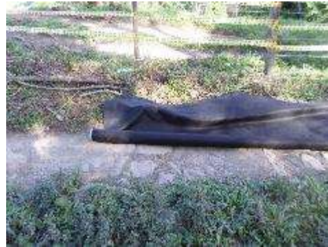
Fotografía 5-18. Instalación geotextil. Puente 4 Punto 7
