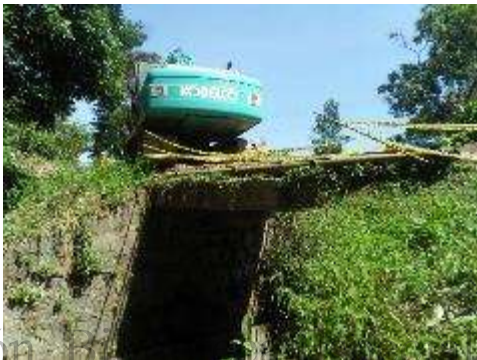
Fotografía 5-19. Instalación sobre puente 5. 8 .
