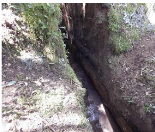
Perfil Occidental, trinchera 2 del Canal con muro a un lado. Detalle de canal
