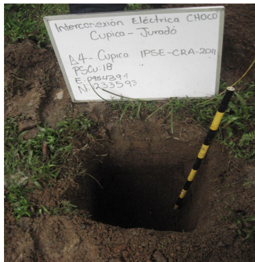
Foto 11. Pozo en el delta 4, en el casco urbano de cupica.
