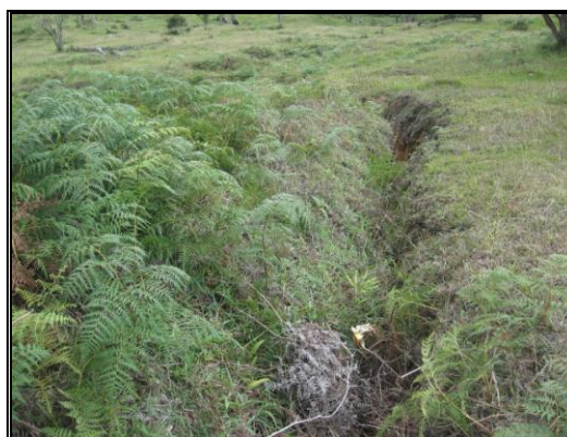
Fotografía 10. Surcos sobresalientes en Área 2
