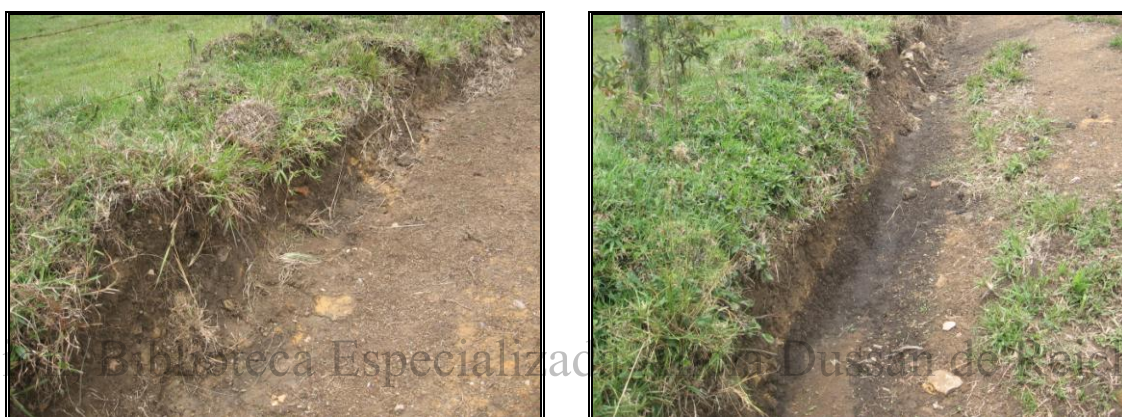
Fotografía 3 y 4. Revisión de perfiles de caminos
