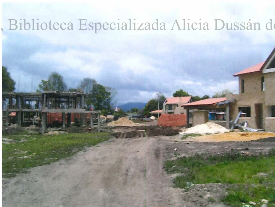
Foto 8. Inspección de la zona removida
