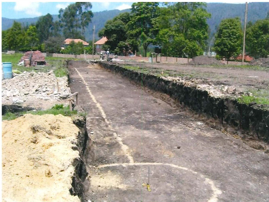
Foto 7. Remoción de suelos
