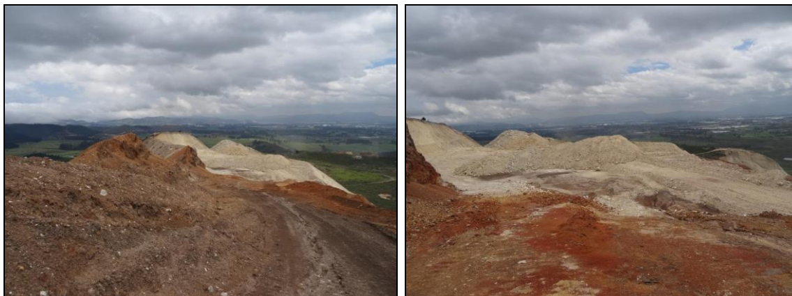
Fotos N°32 y 33. Último sector de la cantera en el costado oeste.
