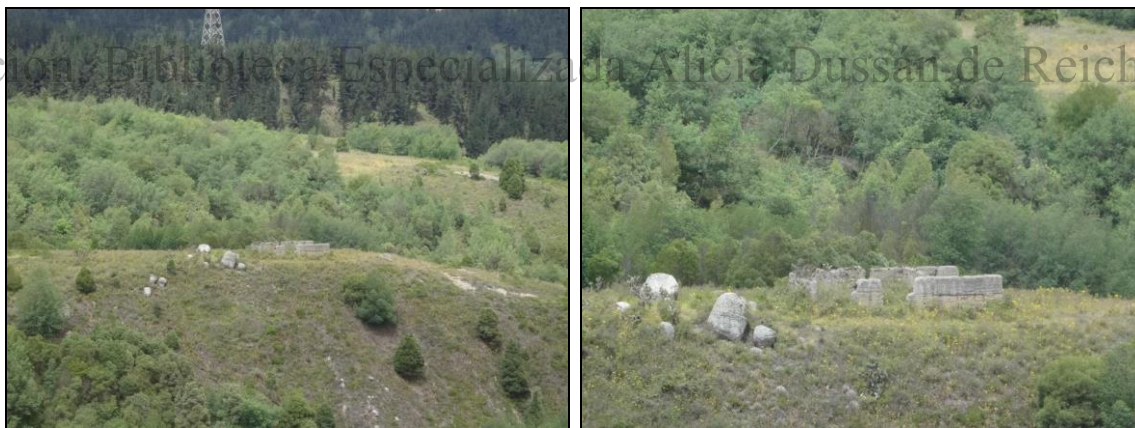
Fotos N°52 y 53. Estructura en barro de una antigua vivienda.
