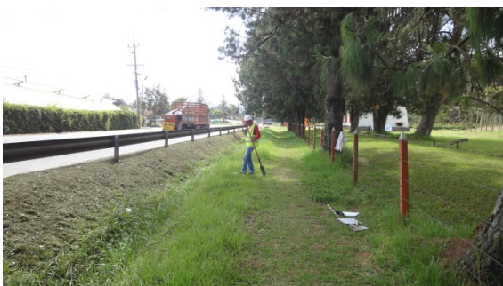
FOTO 84. REALIZACIÓN POZOS DE SONDEO, ZONA 3, TRAMO 4
