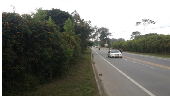
FOTO 16. TRAZADO VIAL SOBRE RETIRO DE VÍA. ZONA 2, TRAMO 1
