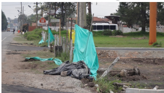
FOTO 91. ACUMULACIONES DE ESCOMBROS Y BASURAS
