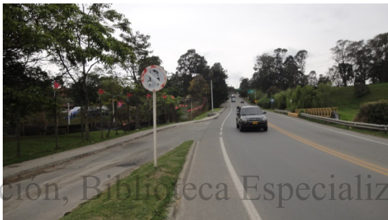
FOTO 4. ZONA DE PENDIENTE SUAVE A MEDIA TRAMO 1
