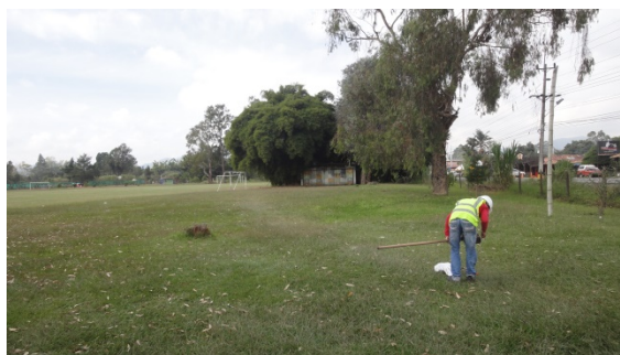
FOTO 94. REALIZACIÓN POZOS DE SONDEO PARTE INTERNA DEL PREDIO, ZONA 1, TRAMO 5
