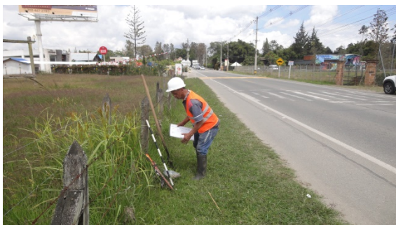
FOTO 75. REALIZACIÓN POZOS DE SONDEO, ZONA 2, TRAMO 4
