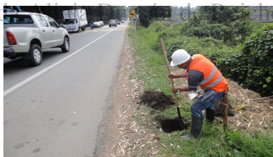
FOTO 129. REALIZACIÓN POZO DE SONDEO 52, ZONA 4, TRAMO 9
