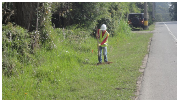
FOTO 64. REALIZACIÓN POZOS DE SONDEO PARTE EXTERIOR DEL PREDIO, ZONA 1, TRAMO 4
