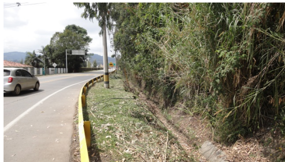
FOTO 104. CAÑO DENTRO DEL TRAMO 6
