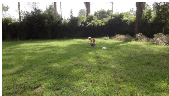
FOTO 66. REALIZACIÓN POZOS DE SONDEO PARTE INTERIOR DEL PREDIO, ZONA 1, TRAMO 4
