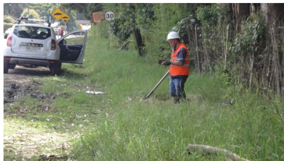
FOTO 42. REALIZACIÓN POZOS DE SONDEO PARTE EXTERNA DEL PREDIO ZONA 2, TRAMO 2
