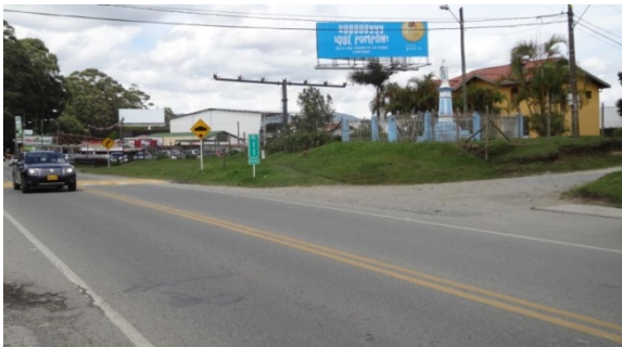
FOTO 53. VISTA GENERAL DE LA VIA EN EL TRAMO 3
