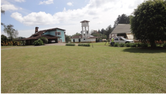
FOTO 33. INFRAESTRUCTURAS DENTRO DEL PREDIO, ZONA 1, TRAMO 2
