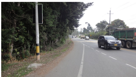
FOTO 122. PAISAJE ASOCIADO A LA ZONA 1, TRAMO 9
