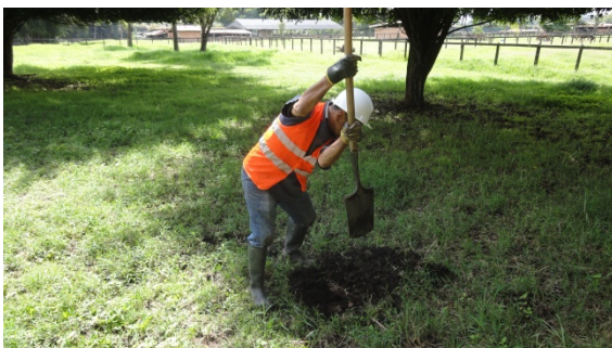
FOTO 30. REALIZACIÓN DE POZOS DE SONDEO ZONA 1 SECTOR 2, DENTRO DEL PREDIO
