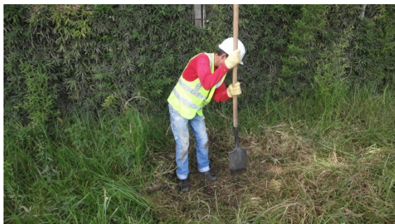
FOTO 46. REALIZACIÓN POZOS DE SONDEO ZONA 2, TRAMO 2
