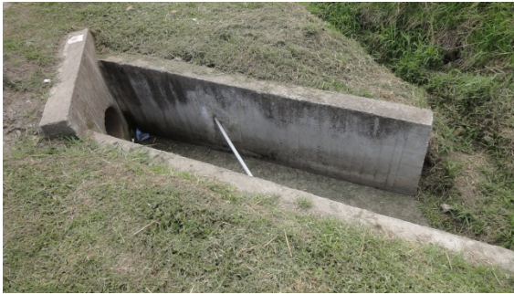
FOTO 107. BOX CULVERT ZONA 1, TRAMO 6
