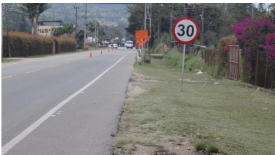
FOTO 105. PAISAJE ASOCIADO A LA PARTE MEDIA DEL TRAMO 6
