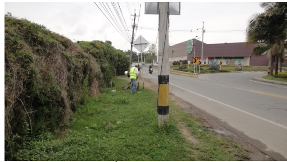
FOTO 7. REALIZACIÓN POZOS DE SONDEO, POSTES DE LUZ DENTRO DE LA ZONA 1, TRAMO 1
