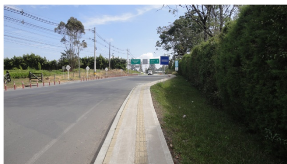
FOTO 123. INFRAESTRUCTURAS DENTRO DE LA ZONA 1, TRAMO 9
