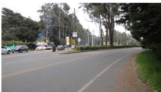
FOTO 120. INICIO DEL TRAMO 9
