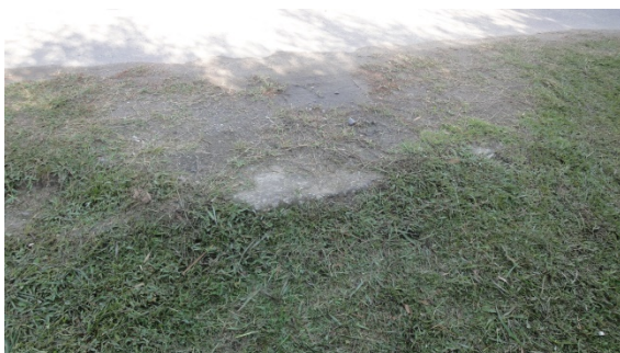
FOTO 31. PLACA DE CEMENTO EN SUPERFICIE ZONA 1, TRAMO 2
