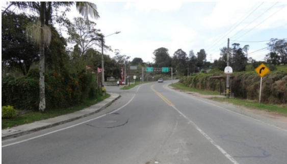
FOTO 2. TRAMO 1. INICIO DE LA VÍA
