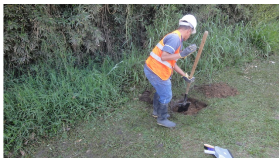
FOTO 28. REALIZACIÓN DE POZOS DE SONDEO ZONA 1 TRAMO 2, POR FUERA DEL PREDIO
