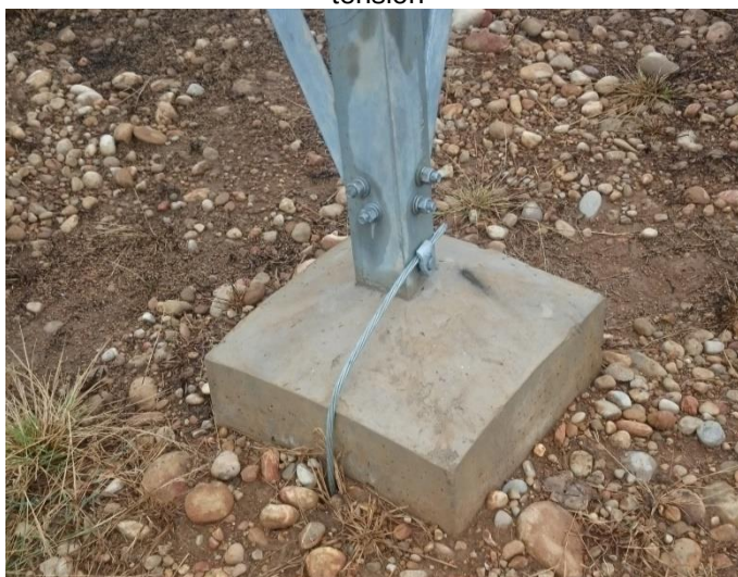
Fotografía 4 Amarre que se le hace a la torre a la base de la misma por medio de un cable de tensión
