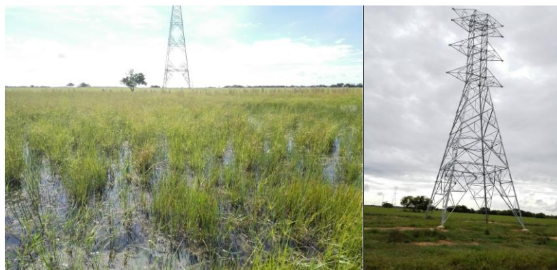
Fotografía 7. Áreas de sondeos descartados por espejos de agua (derecha) y por infraestructuras (izquierda).
