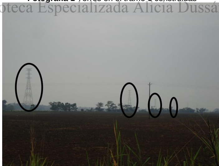
Fotografía 1 Torres en el tramo 1 construidas
