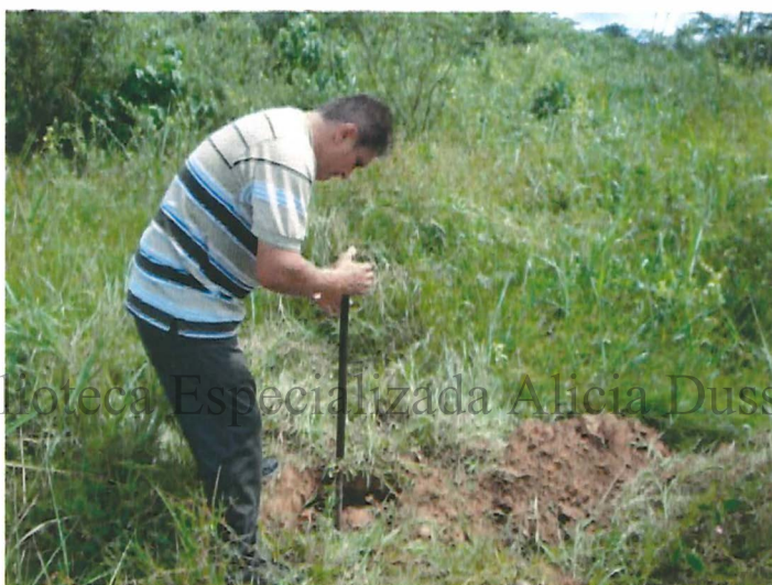
Foto N°3. Excavación de pozos de sondeo.
