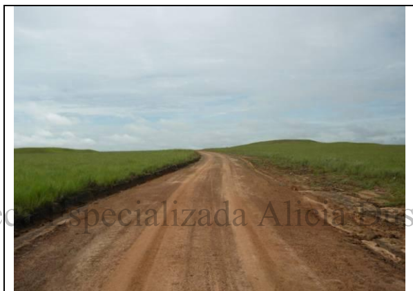
Fotografía 6 Vista de las condiciones actuales de la vía de acceso hacia la localización del pozo Embrujó – 1
