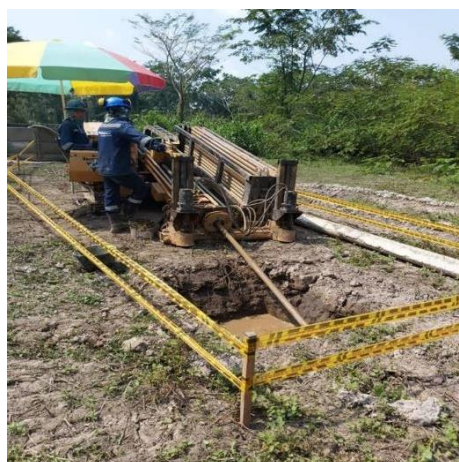
Foto 97. PK 2+553 Taladro plataforma de inicio
