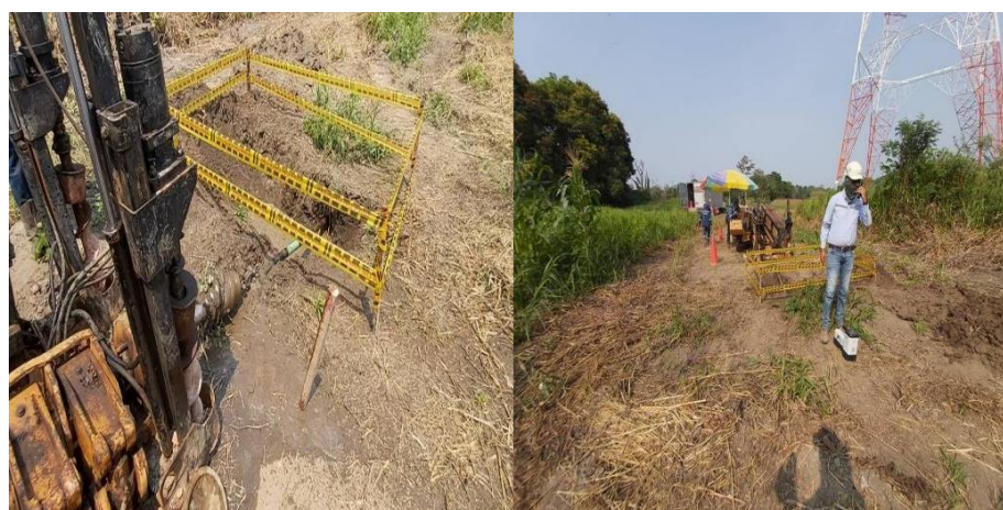
Foto 95. PK 1752 Plataforma Inicio
