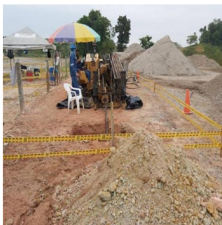
Foto 103. PK 10+878 Plataforma de salida
