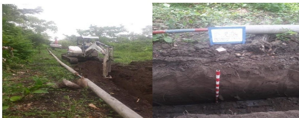
Foto 15. PK 3+236 Contexto Zanjado
