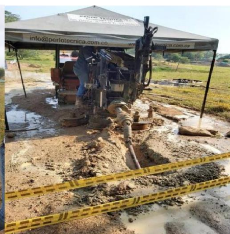
Foto 102. PK 10+608 Apique del taladro
