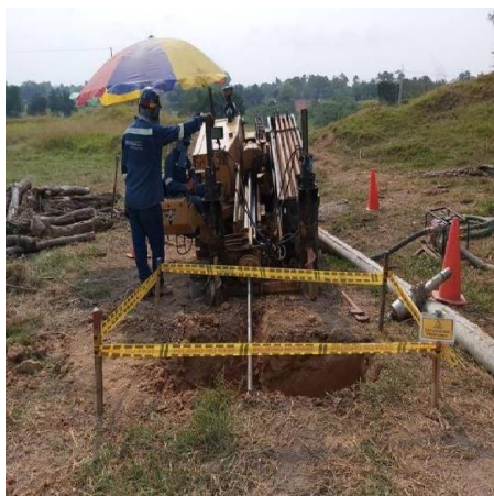
Foto 105. PK 11+261. Plataforma inicial
