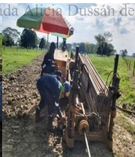
Foto 100. PK 5+824.3 Plataforma de salida
