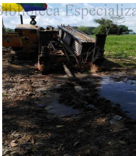
Foto 99. PK 5+740.3 Plataforma Inicio
