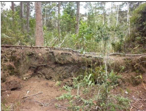
Foto 5. Muro en tierra
