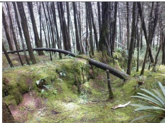
Foto 1. Canal con muro a un lado
