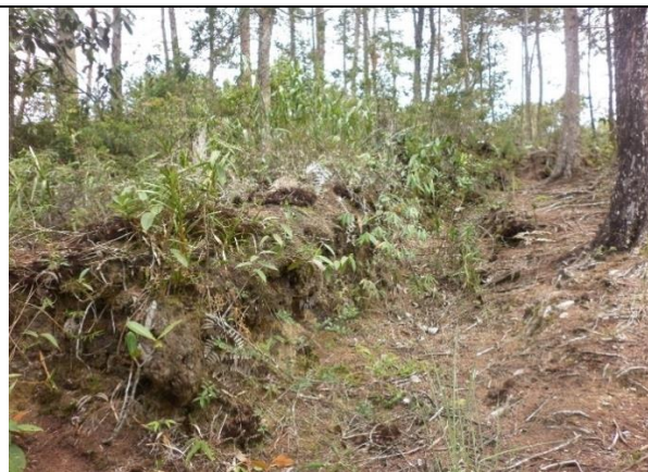
Foto 6. Muro en tierra
