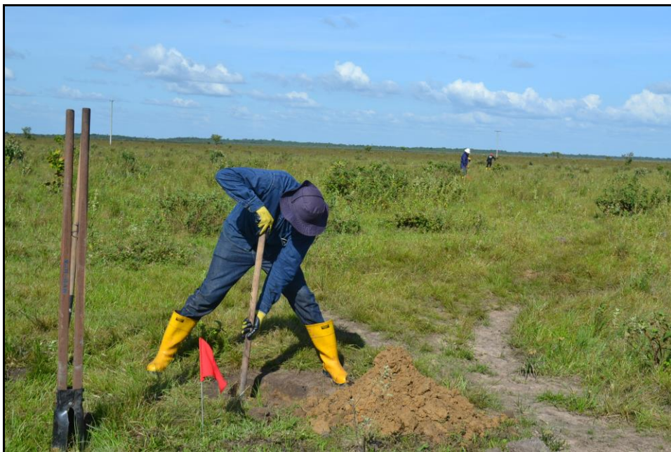
Foto 18. Vireo 3. Línea de Flujo. Excavación de pozos de Sondeo.
