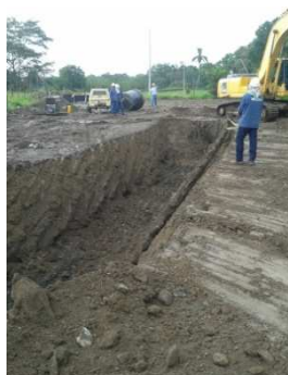
Fotografía 4-66 Desmantelamiento tubería existente cruce Gualí 2 margen izquierda. Enero 2014.
