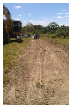
Fotografía 4-51 Adecuación de accesos cruce Gualí 2 margen izquierda. Agosto 2013.
