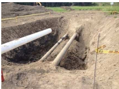
Fotografía 4-36 Excavación para identificar el sitio del Tie-in. Margen izquierda. Cruce Gualí 1. Agosto 2013
