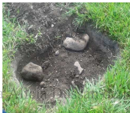
Fotografía 4-53 Apiques para la detección de la tubería cruce Gualí 2 margen izquierda. Julio 2013.
