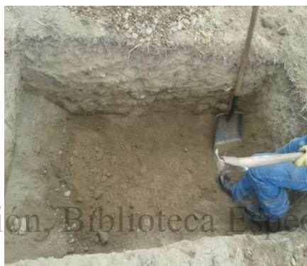
Fotografía 4-52 Apiques para la detección de la tubería cruce Gualí 2 margen derecha. Junio 2013.
