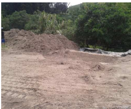
Fotografía 4-48 Descapote Campamentos Margen Izquierda. Cruce Gualí 2. Julio 2013.
