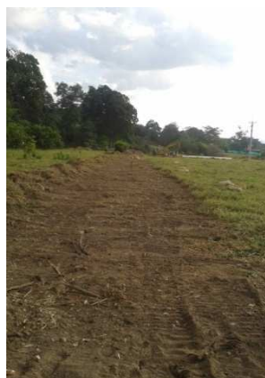
Fotografía 4-54 Derecho de vía cruce Gualí 2 margen izquierda. Agosto de 2013.
