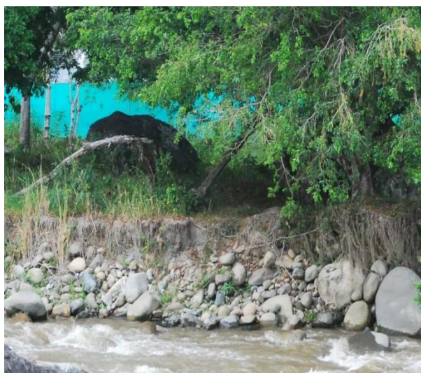
Fotografía 4-13 Perfil de la terraza fluvial sobre el río Gualí margen izquierda. Cruce Gualí 2
