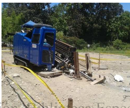
Fotografía 4-60 Perforación piloto margen izquierdo cruce Gualí 2. Agosto 2013.
