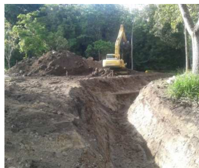
Fotografía 4-35 Zanjado para el bajado de la tubería. Margen derecha. Cruce Gualí 1. Junio 2013.
