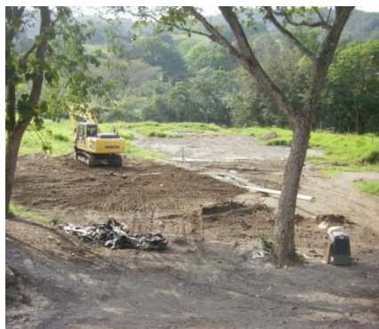
Fotografía 4-68 Re conformación del terreno cruce Gualí 2 margen derecha. Enero de 2013.
