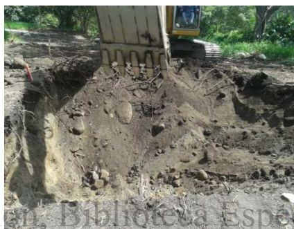
Fotografía 4-38 Excavación para la caja de válvula de retención. Margen derecha. Julio 2013
