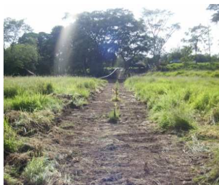
Fotografía 4-49 Descapote Campamentos Margen Derecha. Cruce Gualí 2. Septiembre 2013.
