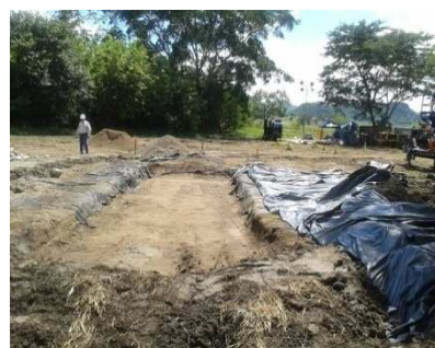
Fotografía 4-30 Piscina para manejo de lodos.
