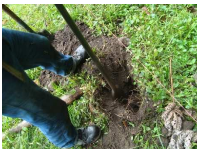
Fotografía 4-28 Apiques para la instalación de estacas para cerramientos temporales. Margen derecha. Cruce Gualí 1. Junio 2013.
