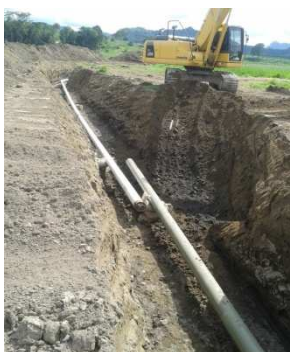
Fotografía 4-34 Zanjado para el bajado de la tubería. Margen izquierda. Cruce Gualí 1. Junio 2013.
