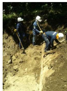
Fotografía 4-37 Excavación para identificar el sitio del Tie-in. Margen derecha. Cruce Gualí 1. Agosto 2013
