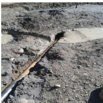
Fotografía 4-32 Punto de entrada de la perforación. Margen derecha. Cruce Gualí 1. Junio 2013.
