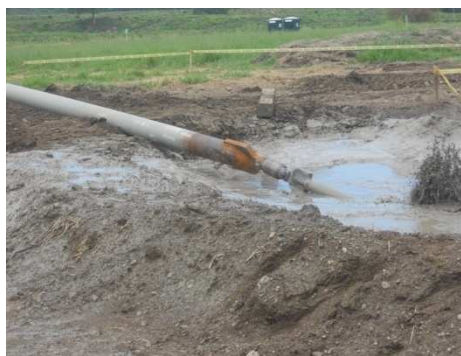
Fotografía 4-33 Punto de salida de la perforación. Margen izquierda. Gualí 1. Agosto 2013.
