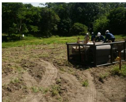
Fotografía 4-26 Apertura derecho de vía. Margen derecha. Cruce Gualí 1. Julio 2013.
