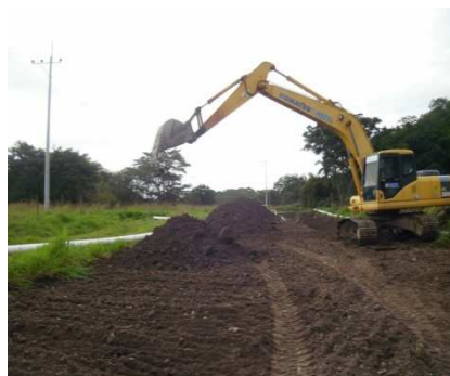
Fotografía 4-69. Re conformación del terreno cruce Gualí 2 margen izquierda. Enero de 2013.
