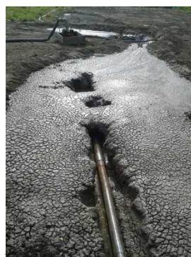
Fotografía 4-61 Perforación piloto margen izquierdo cruce Gualí 2. Agosto 2013.
