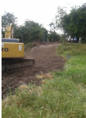
Fotografía 4-50 Adecuación de accesos cruce Gualí 2 margen derecha. Agosto 2013.
