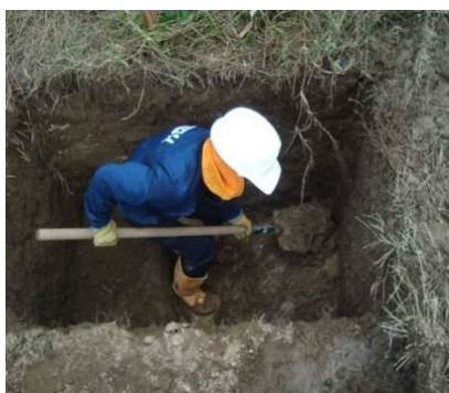
Fotografía 4-24 Localización de la tubería existente 8". Cruce Gualí 1. Margen derecha. Mayo 2013.
