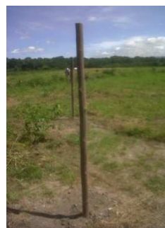
Fotografía 4-29 Apiques para la instalación de estacas para cerramientos temporales. Cruce Gualí 1. Margen izquierda. Junio 2013.
