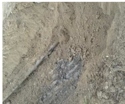
Fotografía 4-67. Desmantelamiento tubería existente cruce Gualí 2 margen derecha. Enero 2014.
