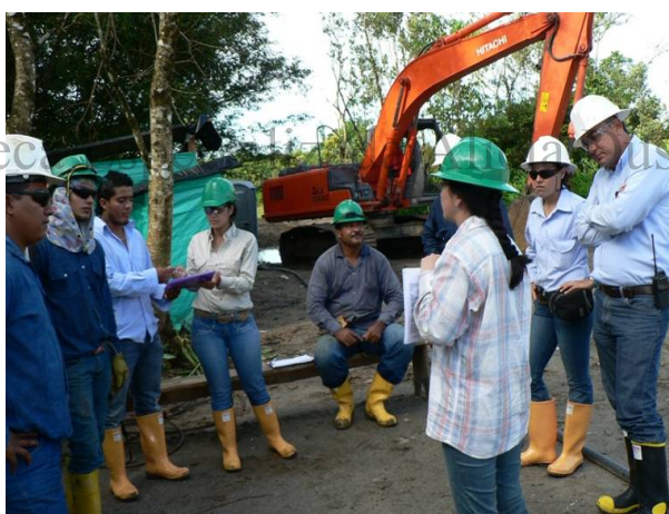
FOTO 18. CHARLA AL PERSONAL DEL SEGUNDO FRENTE DE OBRA.
