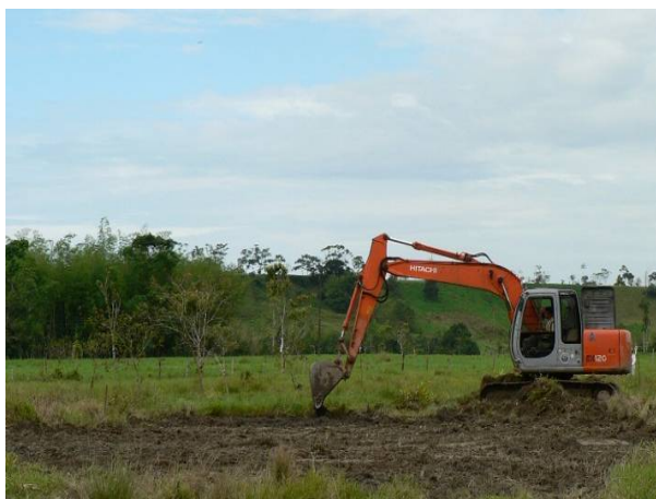
FOTO 10. DESCAPOTE EN EL K 3 + 540, AL FONDO SE OBSERVA LA MESETA SOBRE LA CUAL SE UBICA LA PLATAFORMA DE COSTAYACO 7 Y LOS PRIMEROS DOS KILÓMETROS DE LA LÍNEA.
