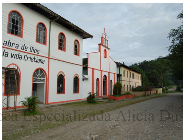
FOTO 1. ZONA CENTRAL INSPECCIÓN DE PUERTO LIMÓN.
