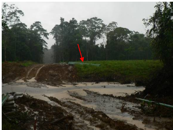
FOTO 3. A LA IZQUIERDA QUEBRADA ANGELITA, HACIA LA DERECHA QUEBRADA LA RUIDOSA, EN AMBAS A LOS COSTADOS SE OBSERVA LA TUBERÍA QUE SERÁ ENTERRADA A 150 CM DE PROFUNDIDAD.
