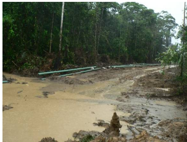
FOTO 3. A LA IZQUIERDA QUEBRADA ANGELITA, HACIA LA DERECHA QUEBRADA LA RUIDOSA, EN AMBAS A LOS COSTADOS SE OBSERVA LA TUBERÍA QUE SERÁ ENTERRADA A 150 CM DE PROFUNDIDAD.
