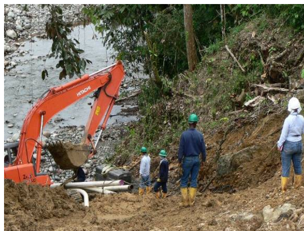
FOTO 16. OBRAS DE ADECUACIÓN DEL TERRENO Y TRANSPORTE DE TUBERÍA EN EL FRENTE DE MOQUETA.
