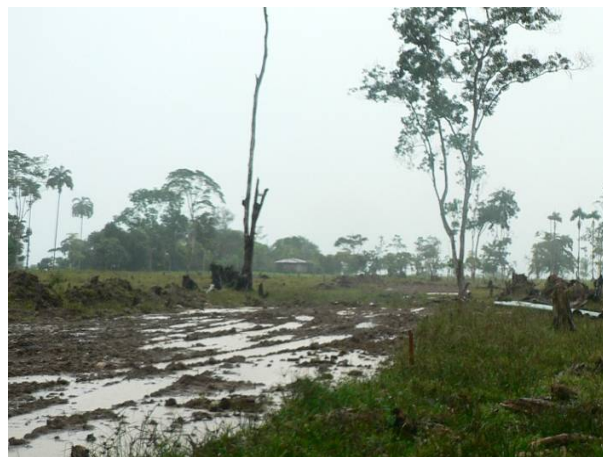
FOTO 5. TERMINACIÓN DE ÁREA DESCAPOTADA K 1+ 500.
