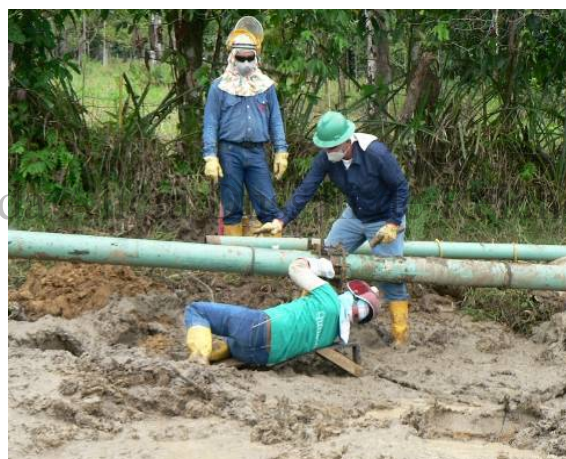
FOTO 9. TRANSPORTE Y SOLDADURA DE TUBERÍA EN K 0 + 700
