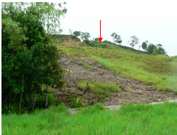
FOTO 7. AL FONDO SE OBSERVA PARTE DE LA MESETA; ZONA MÁS ALTA DE LA LÍNEA DE TRANSFERENCIA DONDE SE SEÑALA EL K 2 + 000 Y AL FRENTE LA QUEBRADA LA BARROSA EN EL K 2 + 200.
