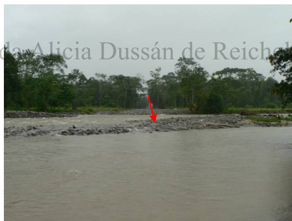
FOTO 12. RÍO MOCOA, AL FONDO SEÑALADO POR LA FLECHA EL FRENTE DE OBRA DOS EN EL K 3 + 500.
