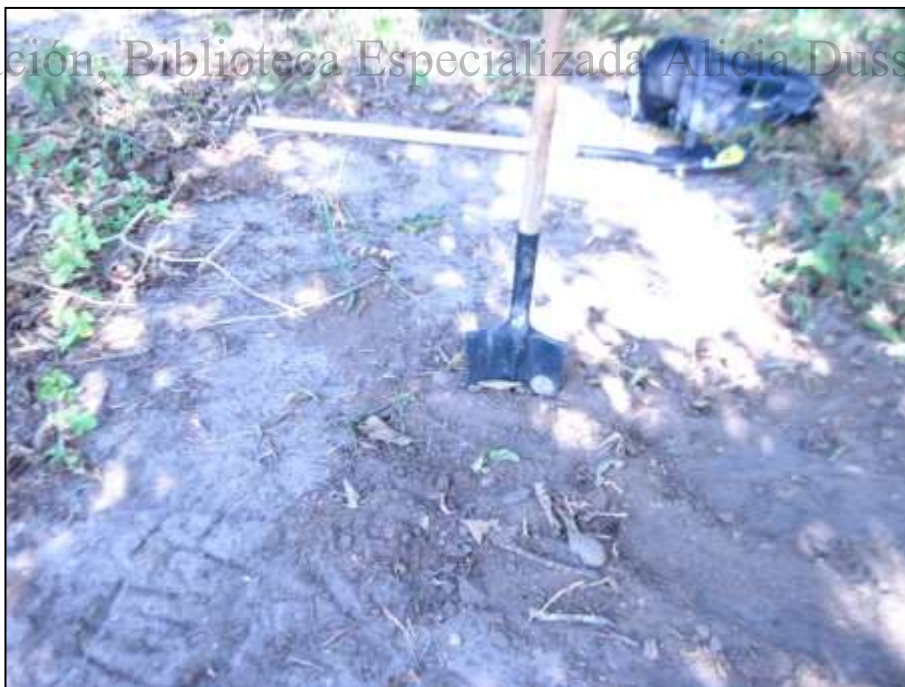
Foto No.1. Iniciación de sondeo No.1 en zona norte.
