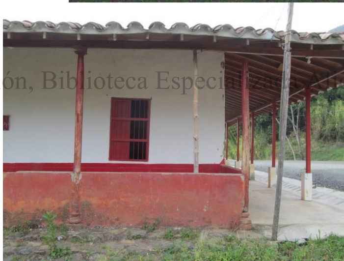
Fotos 23, 24 y 25. Casa antigua del trapiche Carepalo. Se aprecia la intervención en corredor perimetral con un muro de concreto y la ampliación de la casa en uno de sus laterales.
