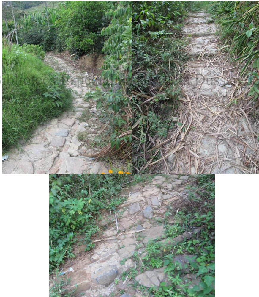
Fotos 11, 12 y 13. Tramo conservado y restaurado del camino Viejo de Occidente donde se pueden ver las estructuras hidráulicas en el centro, y laterales para conducir las aguas
