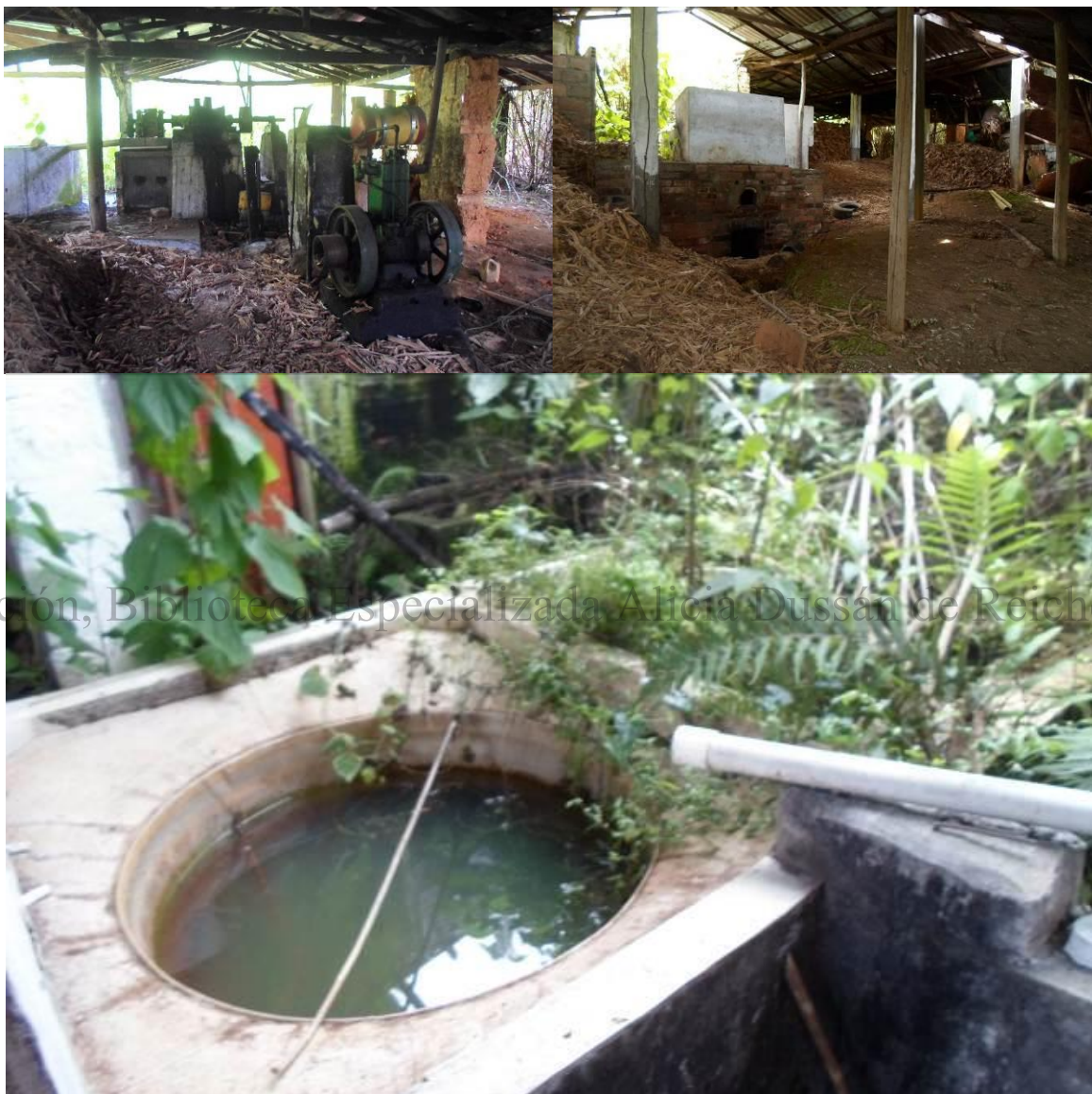
Fotos 34, 35 y 36. Interior del trapiche donde se pueden ver las máquinas e infraestructura para el procesamiento de la caña de azúcar, algunas como las picadoras aún en buen estado. También se pueden ver en la foto inferior, las pailas donde se vierte el guarapo o miel de caña, para luego sacar la panela
