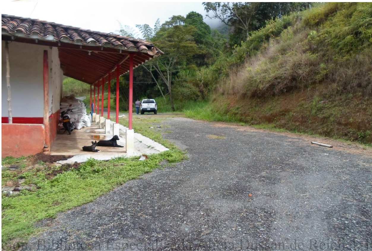
Foto 28. Vista de la casa antigua que se ubica en el centro del polígono del proyecto y de las intervenciones como el parqueadero y los cortes de talud para la explanación del mismo.
