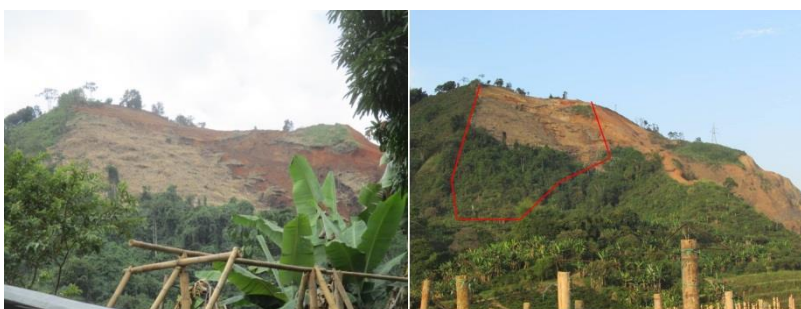
Imagen 16 Área donde se ubicaba un guadua e intervenida con maquinaria en la parte alta y con deslizamiento (17 de agosto y 5 de septiembre 2019)
