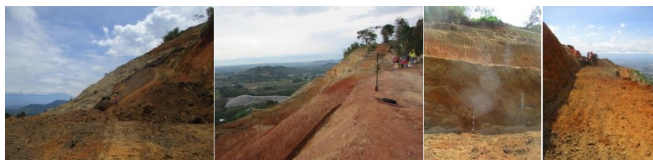
Imagen 19 Ladera de antiguo guadua y vía de acceso en la parte media del polígono, taludes de p.s.243 a 292 norte-sur y sur a norte, y terraza en construcción del AIA 2
