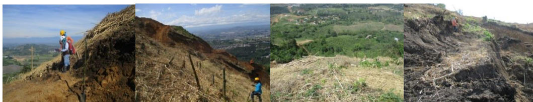
Imagen 18 Ubicación con GPS del punto 213 y 274, vista de norte a sur de la ladera y agrietamientos (p.s.264)
