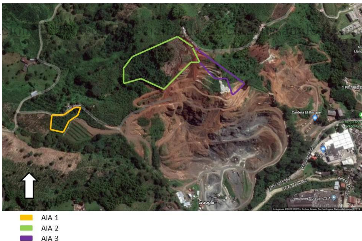
Ilustración 2 AIA1, AIA2 y AIA3 con afectaciones Fuente: (Google, 2019)
