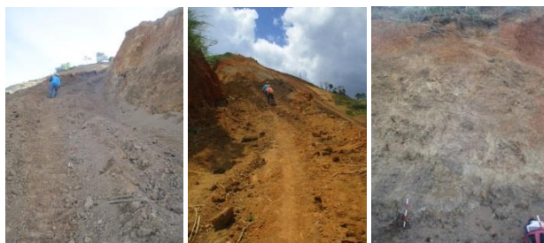
Imagen 17 Vista de ascenso parte alta y talud expuesto (aprox. Punto 170 AIA 2)
