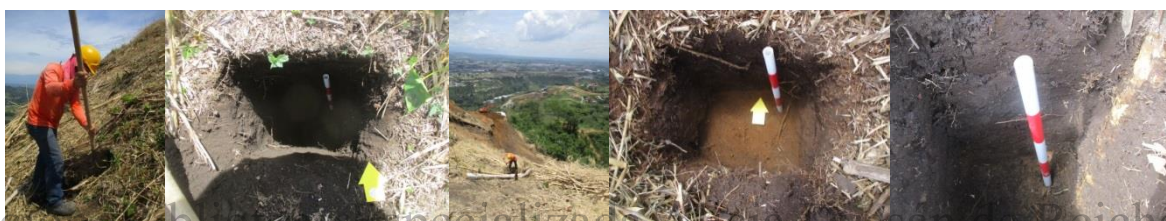
Imagen 21 Proceso de excavación de pozos de .275, 249 y 246 respectivamente
