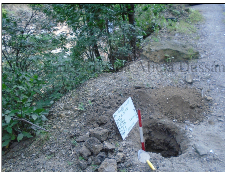
Figura 15. Tramo 4 costado norte. Fuente: INGETEC 2018
