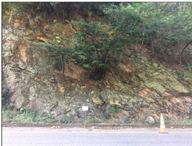
Figura 14. Tramo 4 costado sur. Fuente: INGETEC, 2018
