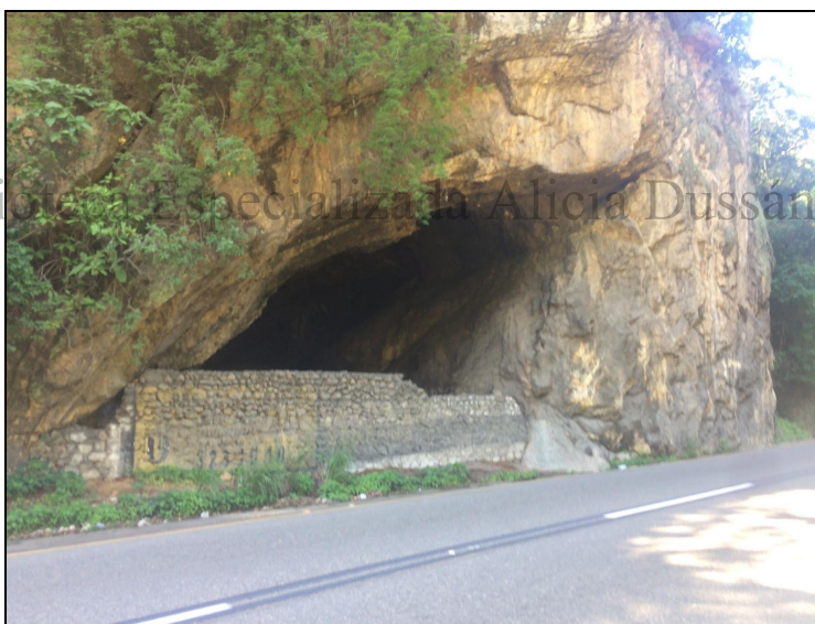
Figura 18. Tramo 5 cueva. Fuente INGETEC 2018
