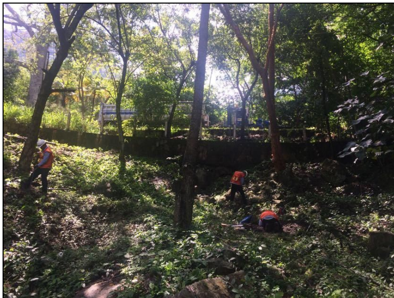
Figura 8. Tramo 2 costado noroccidental de la vía Fuente: INGETEC 2018
