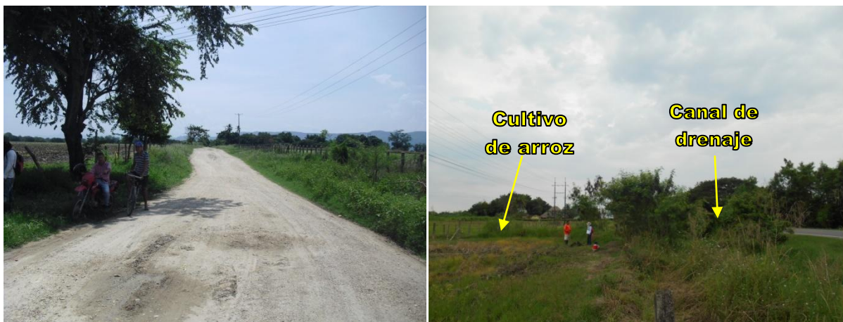
Fotos 49 y 50. Carreteable que conduce al sector El Colegio y canal de drenaje paralelo al terraplén de la vía existente
