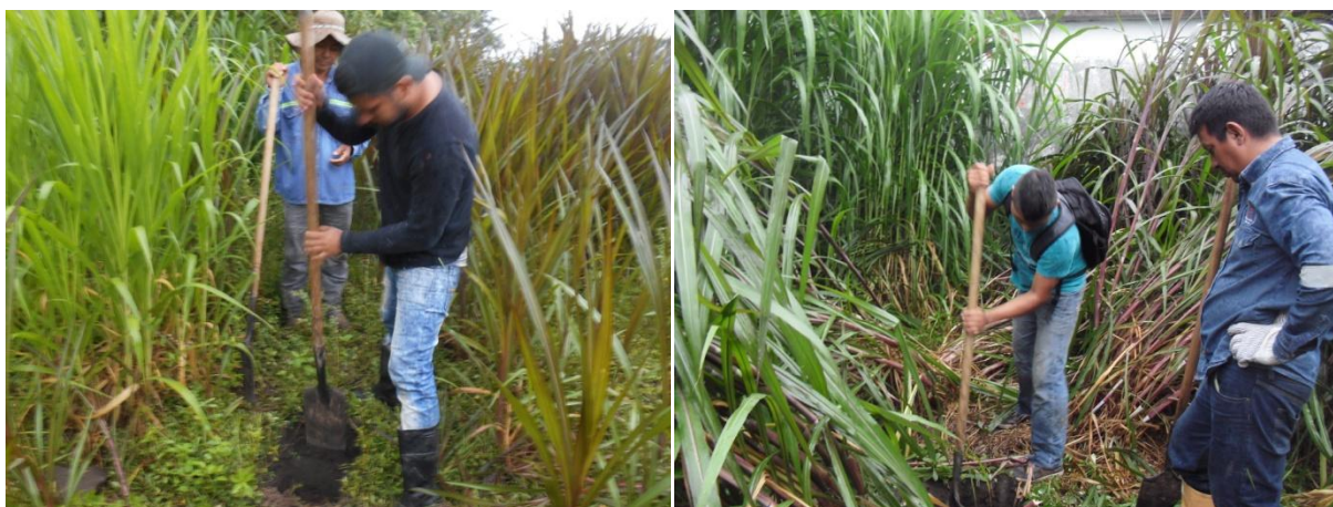
Fotos 83 y 84. Realización de pozos de sondeo
