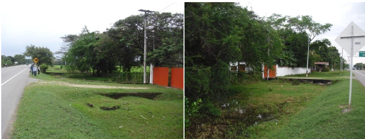
Fotos 11 y 12. Terraplén levantado para la construcción de la vía existente
