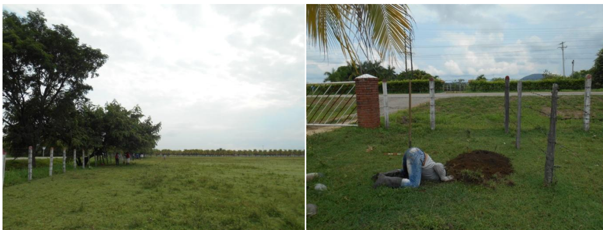
Fotos 75 y 76. Realización de pozos de sondeo
