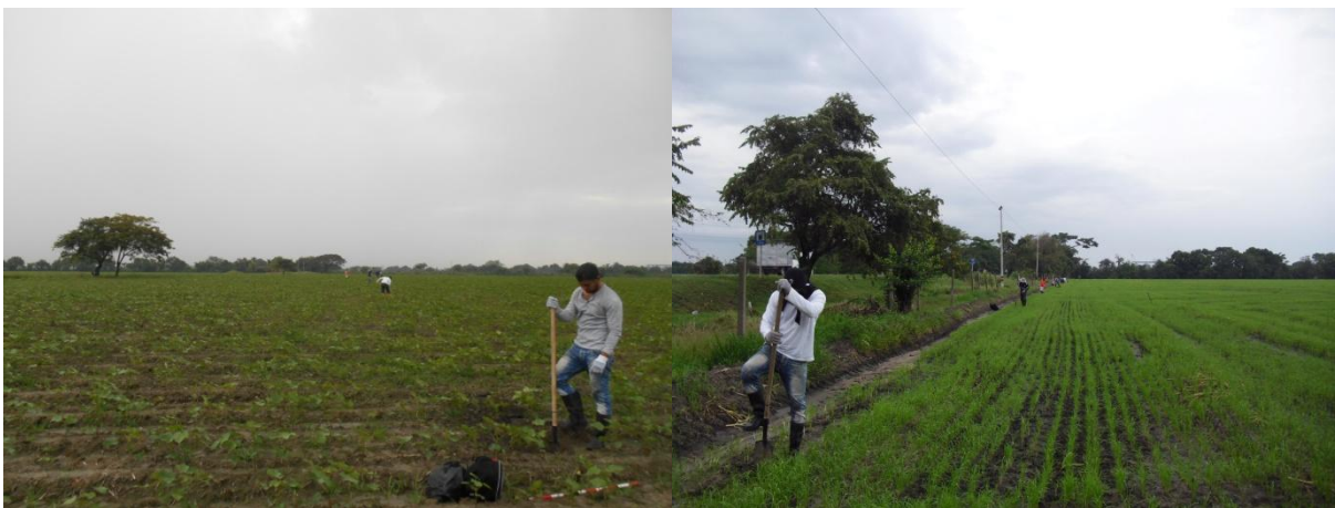
Fotos 1 y 2. Realización de pozos de sondeo cada 25 metros
