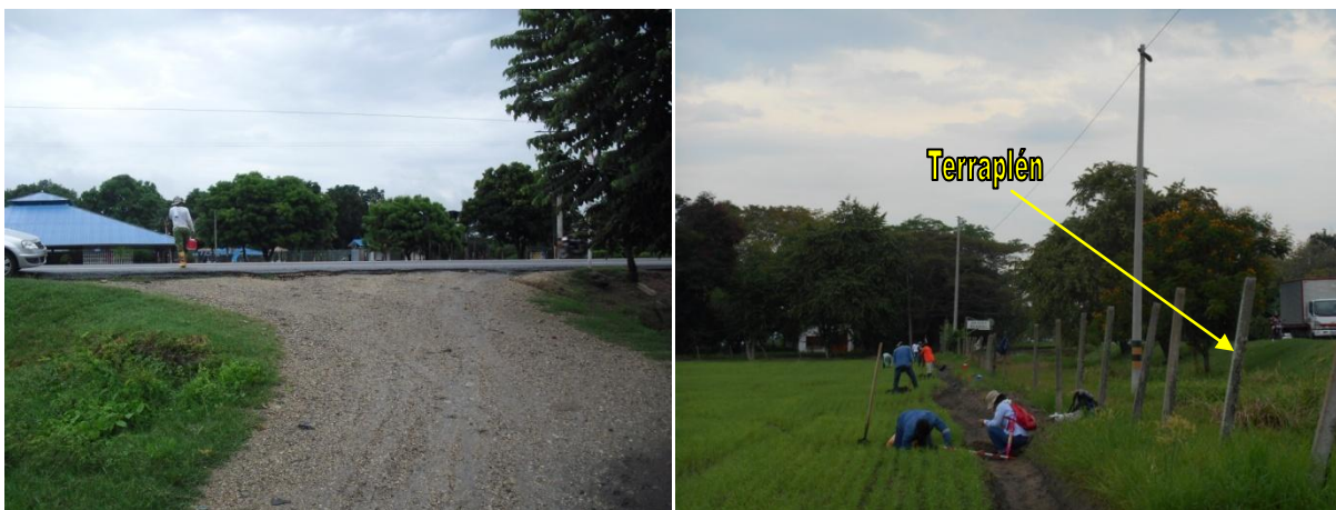
Fotos 47 y 48. Terraplén levantado para la construcción de la vía existente
