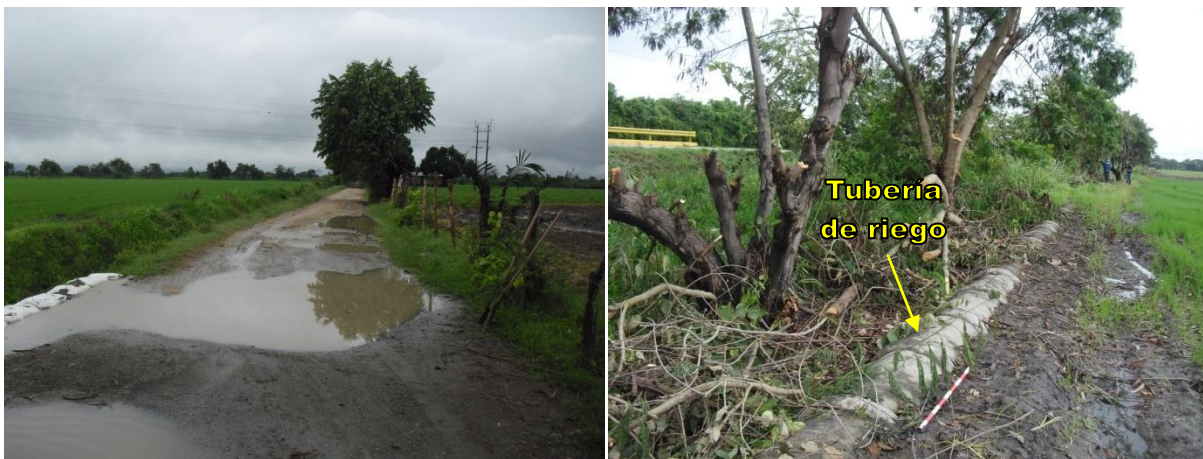
Fotos 57 y 58. Carreteable de acceso a la finca de los Pava Prada y tubería de riego paralela al terraplén de la vía existente
