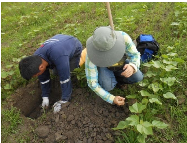
Foto 16. Realización de pozos de sondeo
