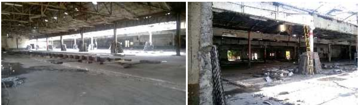
Foto 4: Restos de las edificaciones de los antiguos talleres de PANTEX.
