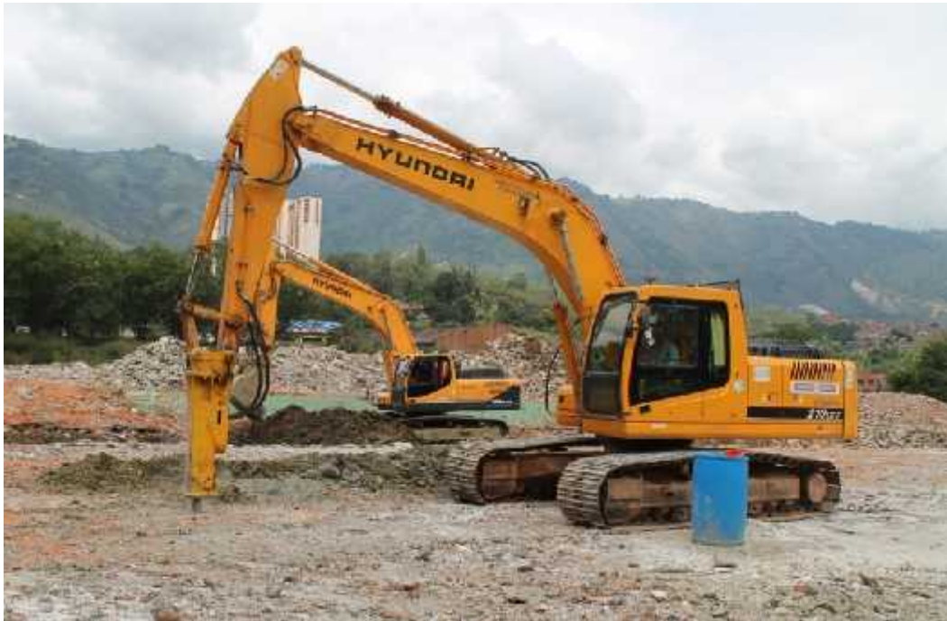
Foto 5: Retroexcavadoras empleadas en el monitoreo arqueológico.
