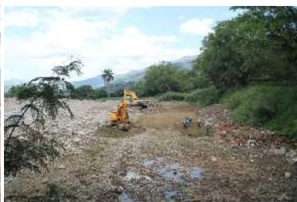
Foto 11: Remoción de suelos por franjas en áreas con placas de concreto.
