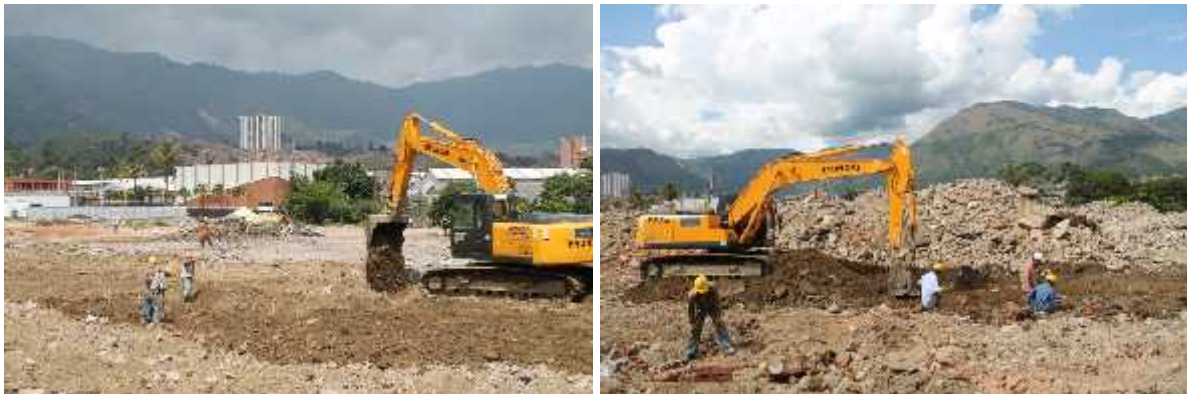
Foto 28: Remoción y revisión de suelos en Subárea 2I.
