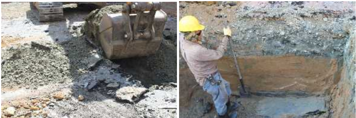
Foto 54: Remoción de pavimento y sondeo con máquina. Subárea 2J.
