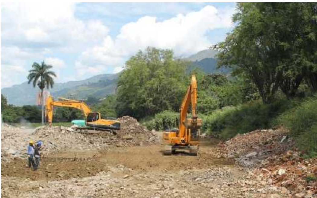
Foto 6: Remoción de placas de concreto, escombros resultantes y rellenos con retroexcavadoras.
