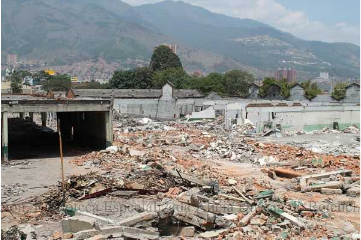
Foto 3: Área de talleres y bodegas de PANTEX en proceso de demolición.
