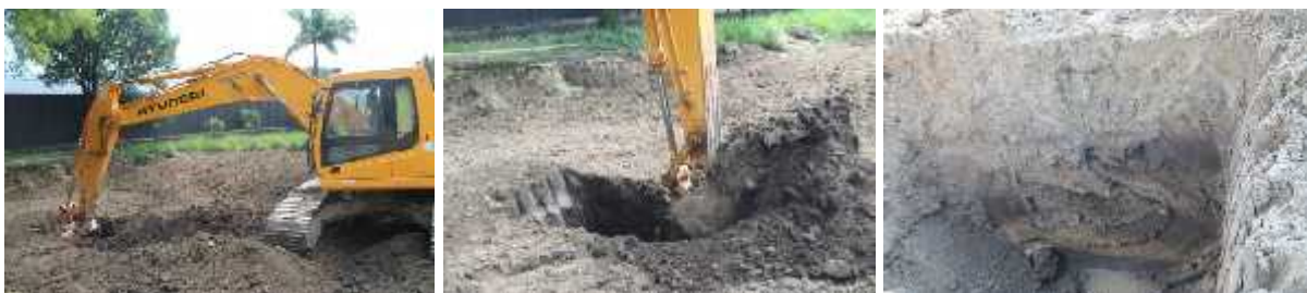
Foto 12: Sondeo con máquina. Sector 2N3.
