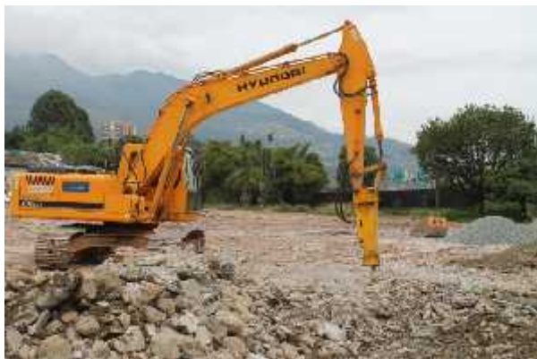
Foto 9: Empleo de martillo hidráulico y “ripper” para el “picado” y el levantamiento de las placas.
