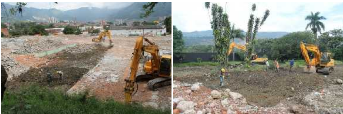
Foto 17: Remoción y revisión de suelos de la Subárea 2N.
