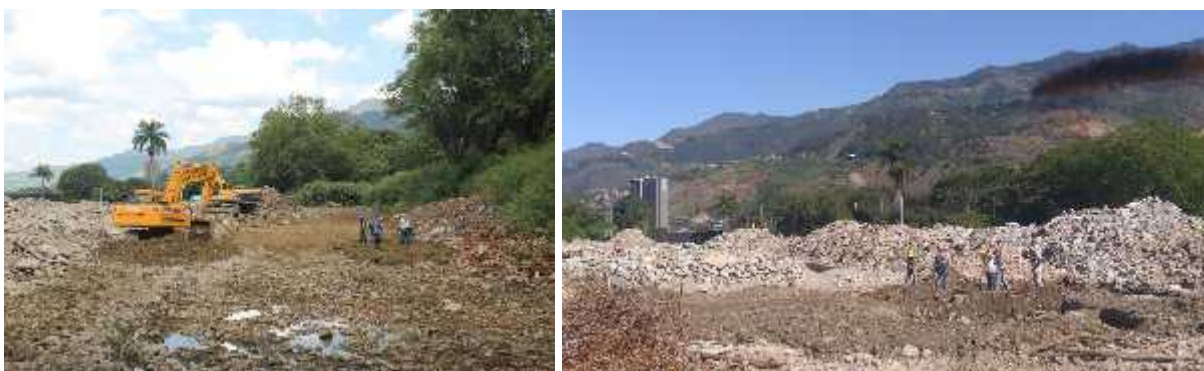
Foto 23: Remoción y revisión de suelos de la Subárea 2M.
