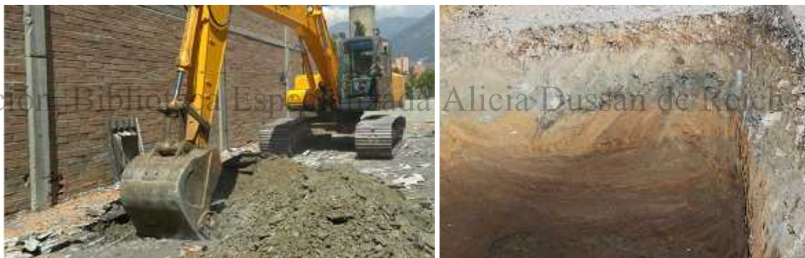
Foto 52: Remoción de pavimento y sondeo con máquina. Subárea 2G.
