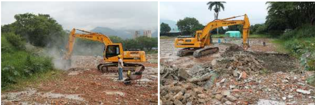
Foto 8: Inicio del levantamiento de placas de concreto.
