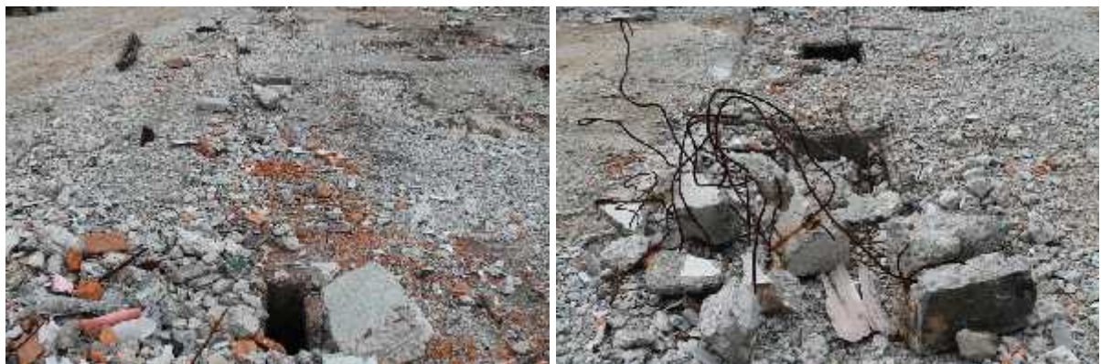
Foto 33: Restos de sistemas de conducción de aguas ("cárcamos" o acequias). Sector 2H2.
