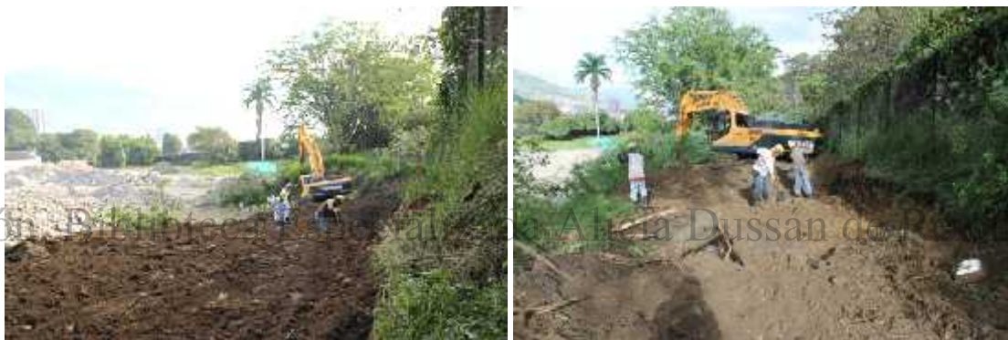
Foto 42: Remoción y revisión de suelos de la Subárea 1D.
