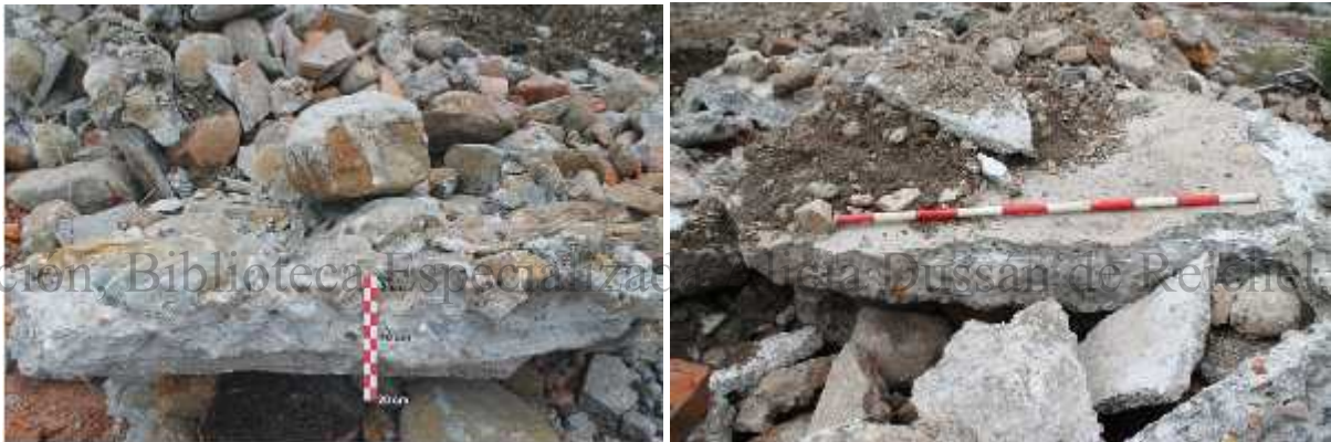
Foto 7: Fragmentos de placas de concreto.
