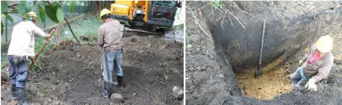
Foto 48: Revisión de suelos y sondeo con máquina. Subárea 2C.
