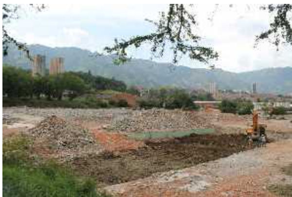
Foto 11: Remoción de suelos por franjas en áreas con placas de concreto.
