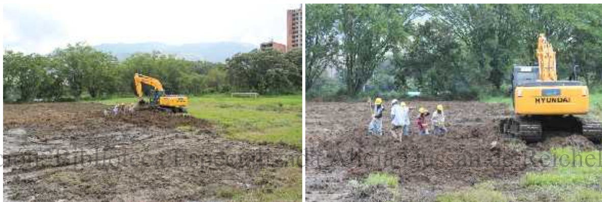
Foto 37: Remoción y revisión de suelos de la Subárea 2L. Cancha de fútbol.
