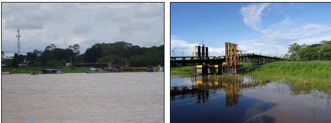
Fotos N°5 y 6. Vista del Muelle Victoria Regia desde Santa Rosa en Perú. Estructura del Muelle sobre aguas del río Amazonas.
