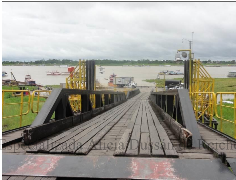
Muelle Victoria Regia sobre el río Amazonas. Frontera colombo-brasilera
