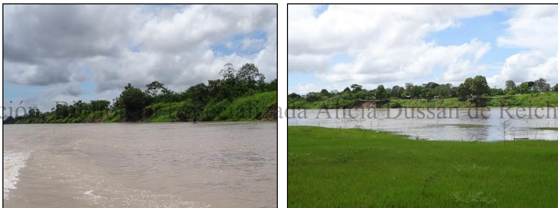
Fotos N°27 y 28. Lugares donde se tiene proyectado construir los cuatro espolones.
