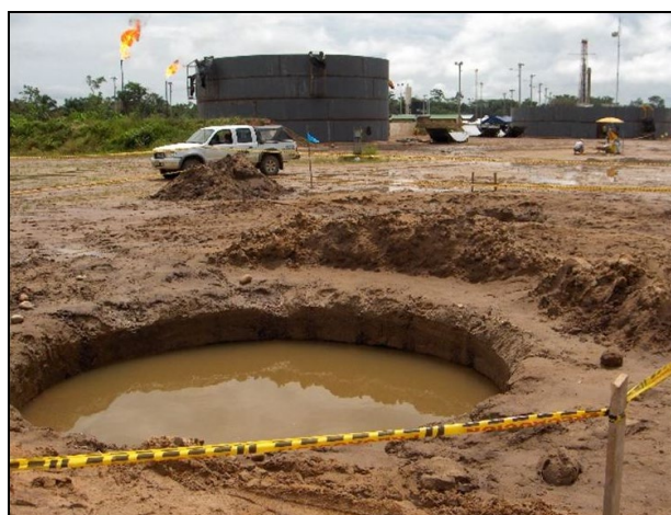
Figura 5. Detalle área del hallazgo (pozo para pilote tanque)
