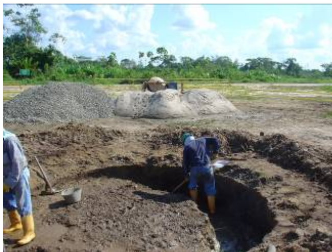
Fotografía 12. Remoción capa de piedras y cemento dispuesta por los obreros.
