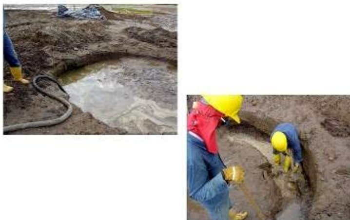
Fotografía 22. Extracción agua acumulada y remoción de capa de relleno piedras y cemento
