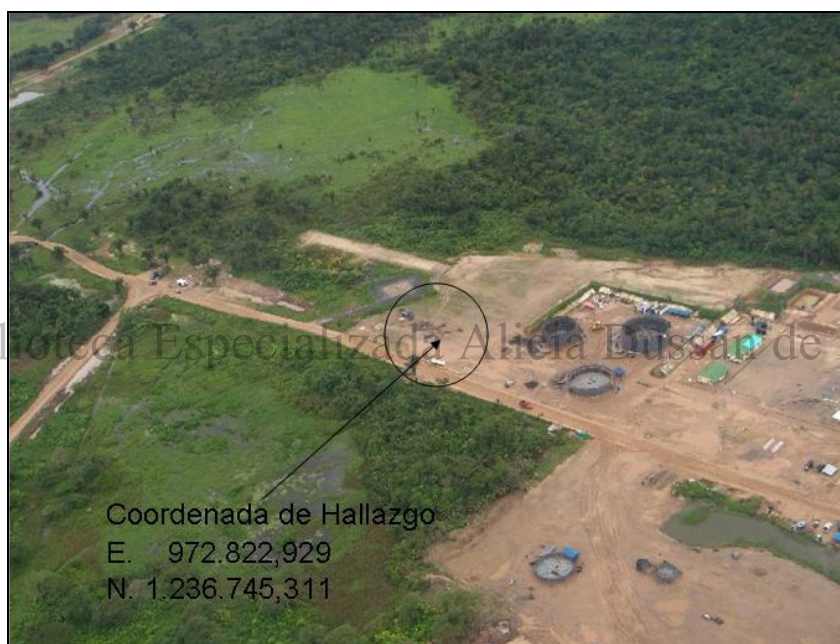
Figura 4. Panorámica actual área del hallazgo
