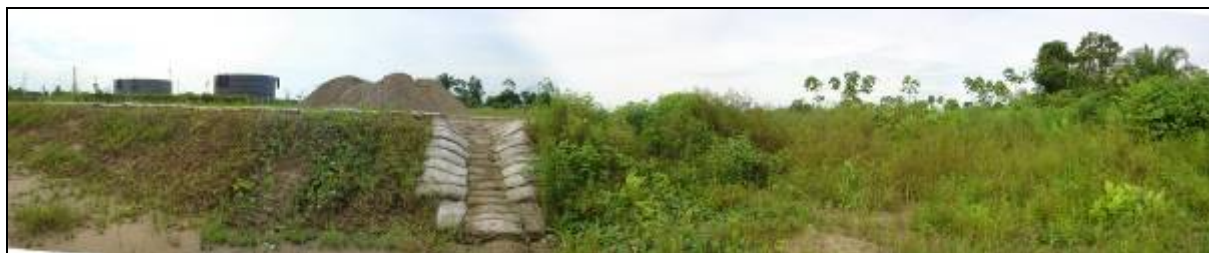
Fotografía 2. Panorámica zona de relleno de arena - 1,5 m de grosor.
