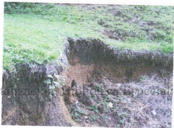
Fotos 36 y 37. Derrumbe por erosión hídrica en el sector nororiental de la zona de depósitos de escombros 3.
