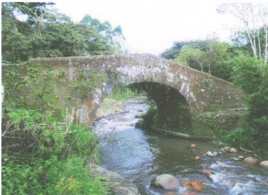
Foto 58. Puente en mampostería sobre el río San Miguel. Coordenadas N 727305,6 – W 1033474,9.
