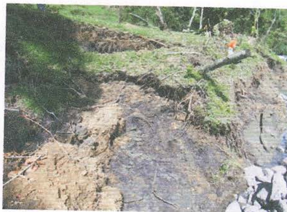
Fotos 4 y 5. Panorámica del sector norte del Campamento Base. Fisuras y desprendimiento del terreno por falla geológica y filtración de agua.
