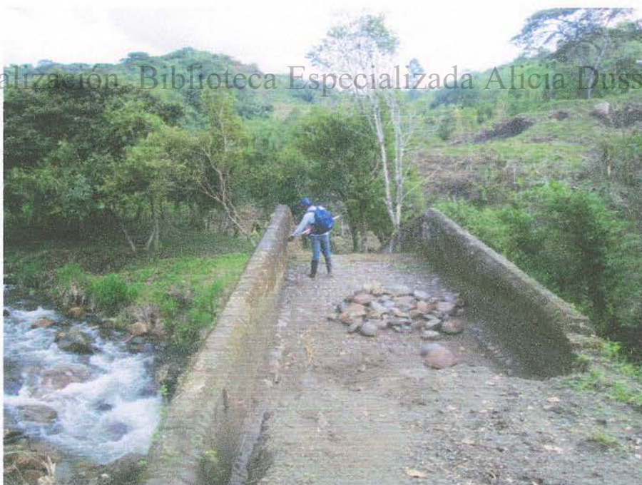
Foto 59. Vista superior y estado actual del puente sobre el río San Miguel
