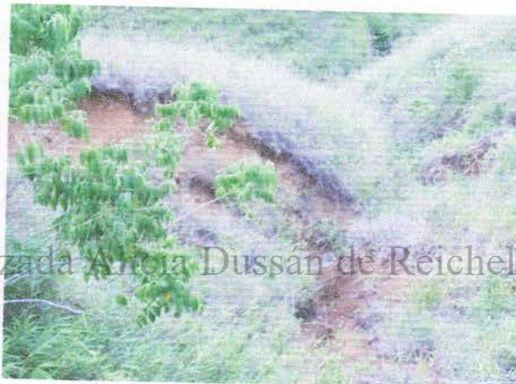
Fotos 36 y 37. Derrumbe por erosión hídrica en el sector nororiental de la zona de depósitos de escombros 3.
