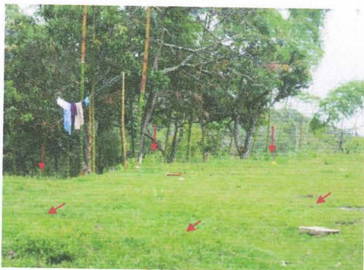
Foto 23. Sector nororiental de la zona 1. Escombros cubiertos por la vegetación y al fondo el deslizamiento en el sector occidental.
