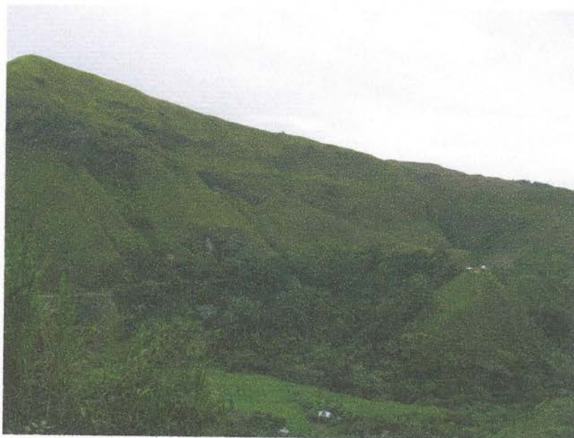
Foto 3. Taludes de alta pendiente en la vía La Sierra – la Vega
