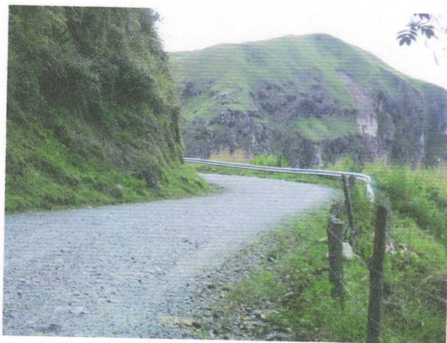
Foto 52. Perfil rocoso, Curva 4. Km 28 + 950.
