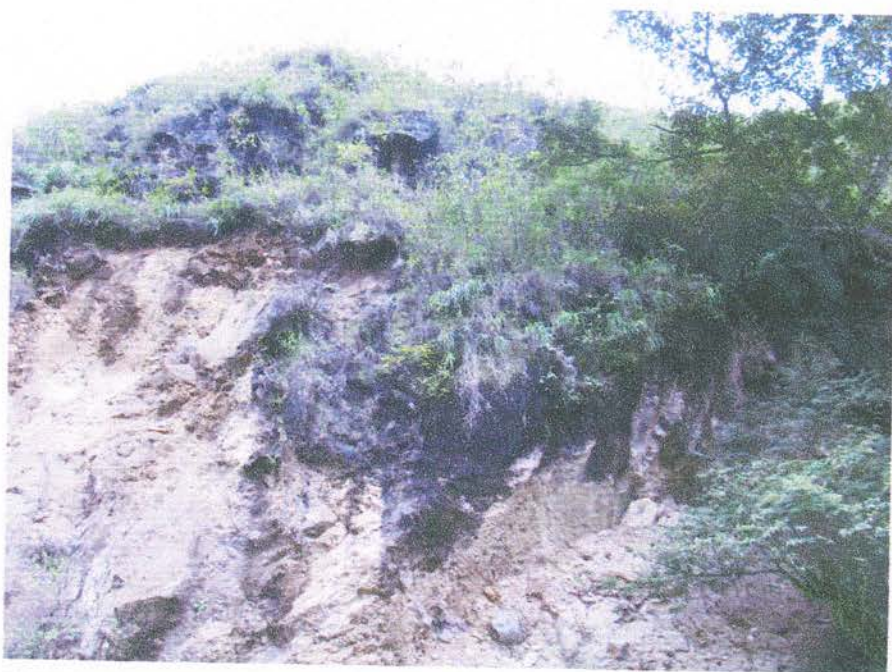
Foto 48. Perfil rocoso, Curva 2. Km 24 + 900, Coordenadas N729918,7- W1034349,0
