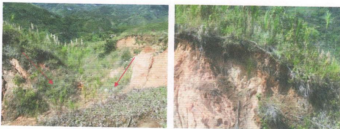
Fotos 40 y 41. Derrumbe del sector sur por erosión hídrica en la zona 3, este talud tiene una altura aproximada de 12 m.
