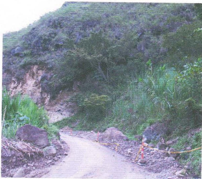
Foto 46. Curva 1. Km 23 + 750, coordenadas N 730468,7 - W1034647,0
