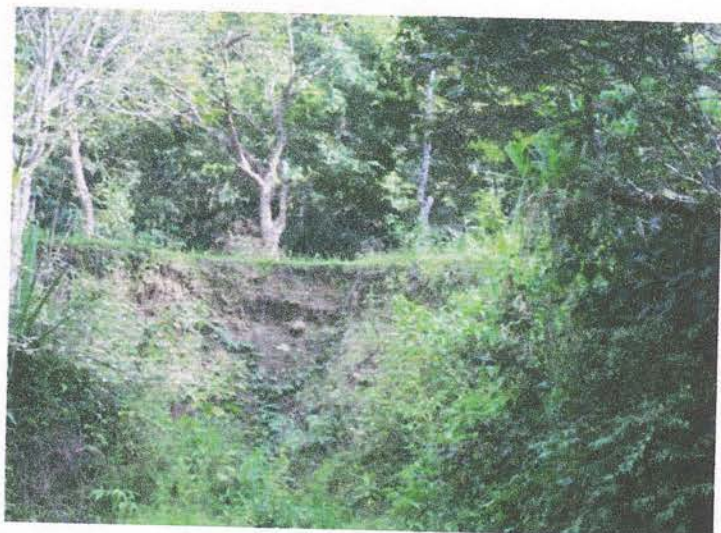
Foto 17. Punto de observación A. Hundimiento del terreno en la zona de depósito de escombros 1.
