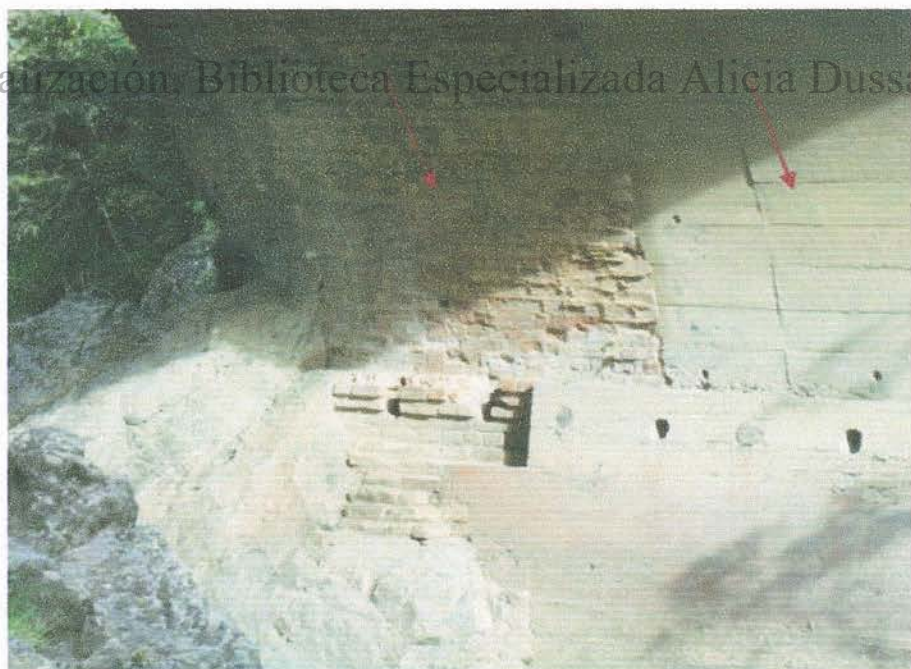
Foto 55. Arco en mampostería y concreto.
