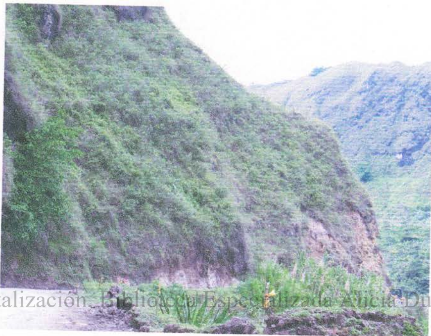
Foto 47. Curva 2. Km 24 + 900, Coordenadas N729956,7 - W1034318,6
