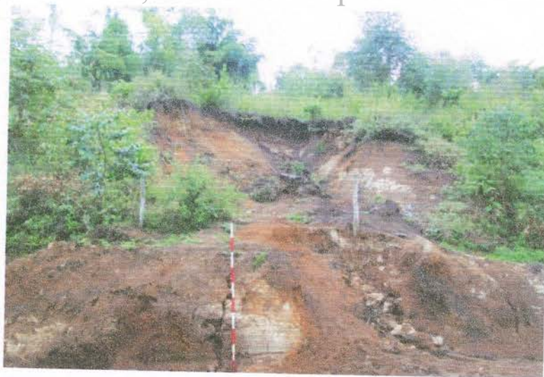
Foto 22. Perfil. Deslizamiento del terreno en el sector occidental de la zona de depósito de escombros1.
