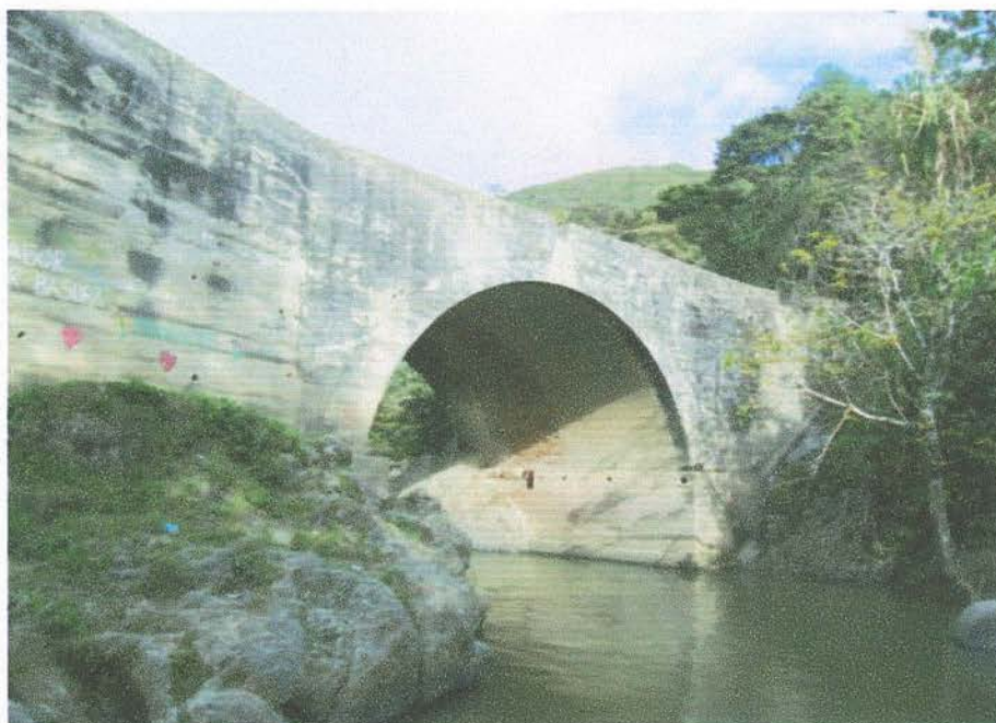
Foto 54. Ampliación en concreto del antiguo puente sobre el río San Pedro.
