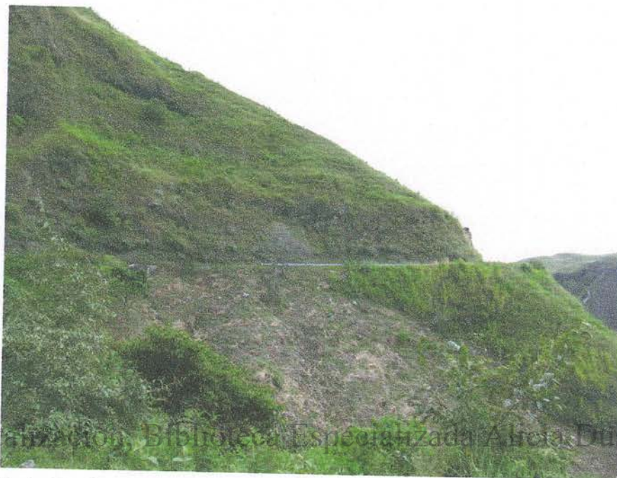
Foto 51. Curva 4. Km 28 + 950, Coordenadas N 729513.8 – W 1032766.2
