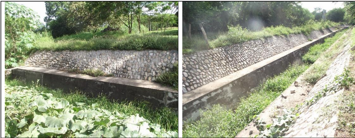
CANAL DE AGUA
