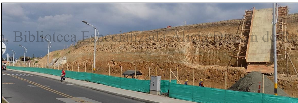
FOTO 4: Panorámica observando hacia el sur oriente del corte reciente de la adecuación de un muro de contención. Se destacan los distintos eventos naturales de formación de la terraza por eventos torrenciales.
