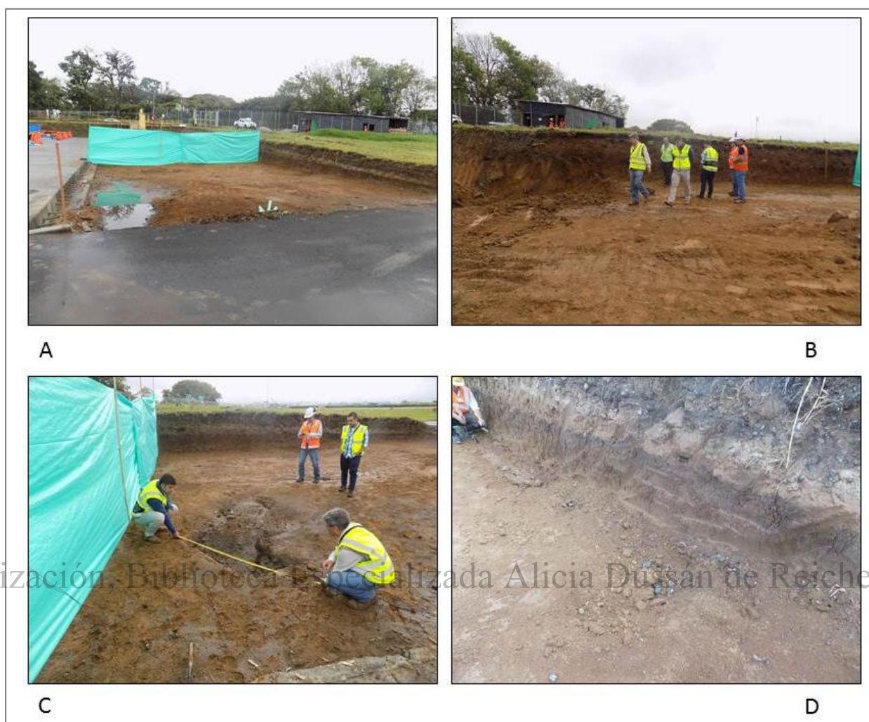
FOTO 10: Secuencia A, B, C Y D. Labores de reconocimiento y mediciones en el área intervenida por la maquinaria. Nótese la existencia de un desarrollo de suelo, sepultado por rellenos antrópicos recientes.
