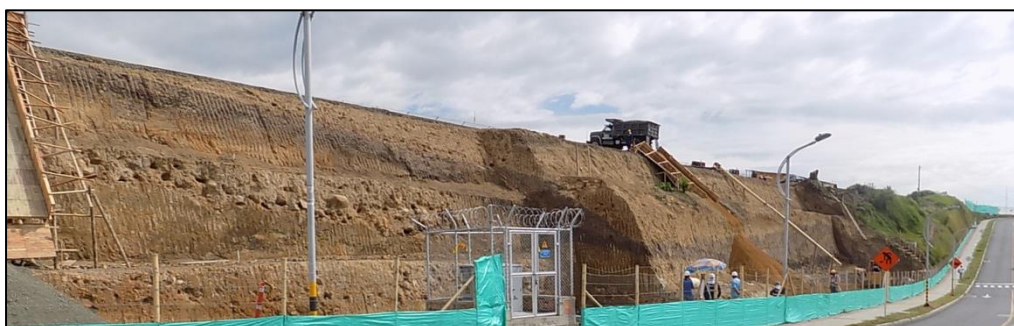
FOTO 5: Panorámica observando hacia el sur occidente del corte reciente de la adecuación del muro de contención. Nótese el suelo enterrado que muestra la paleo-topografía original y la magnitud de los rellenos que tienen algunos sectores de las áreas aledañas a la pista.
